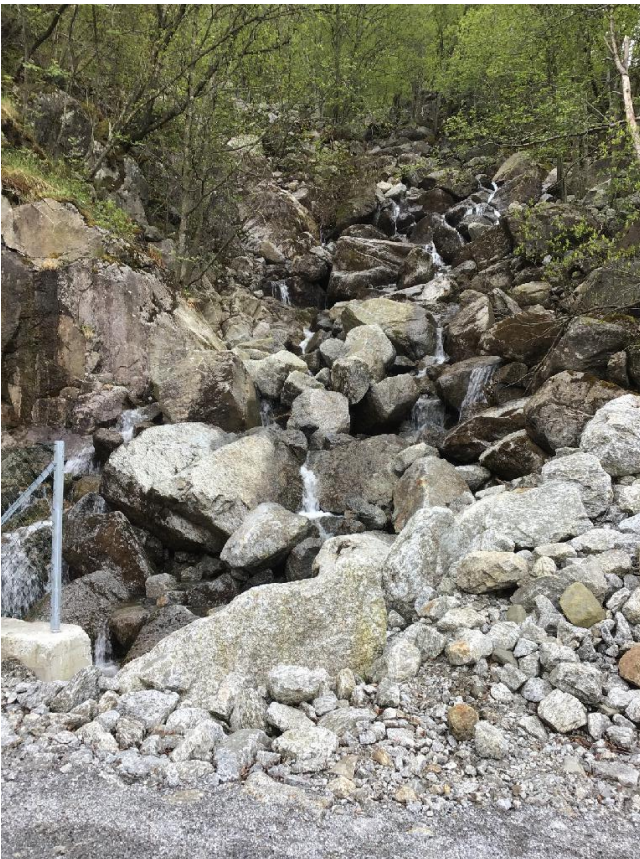
Figur 14. Fra bro og oppover i terrenget.
