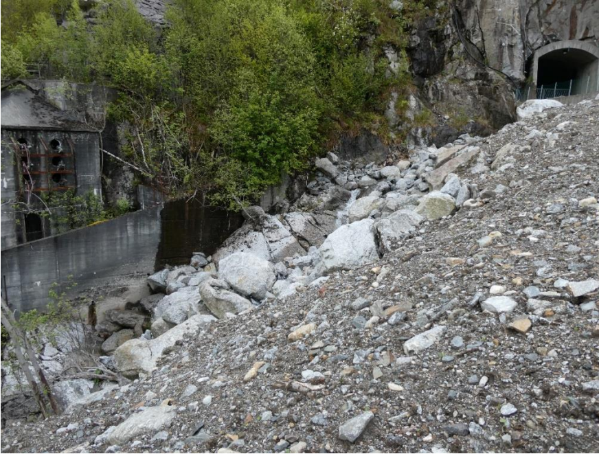
Figur 13 – Masseføring i elva Slevåna. Rv13 ned mot venstre, og omtalt bro til høyre i bildet.
