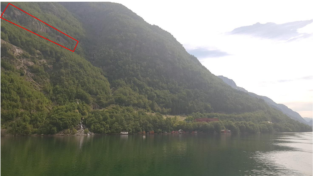
Figur 20 – Rødt omriss markerer nordøstlig potensielt løseområde for steinsprang. Her har det det gått både steinsprang og steinskred ned mot tunnel på Rv13.
