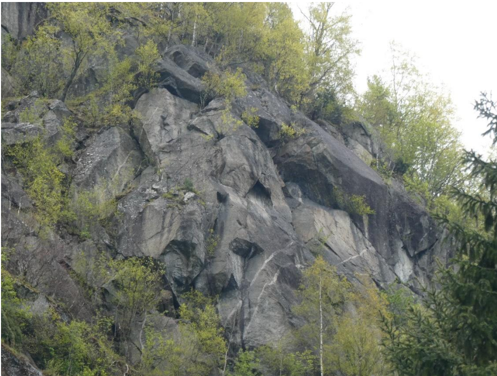
Figur 18 – Oppsprekking i mulig utløsningsområdet like øst for planområdet.
