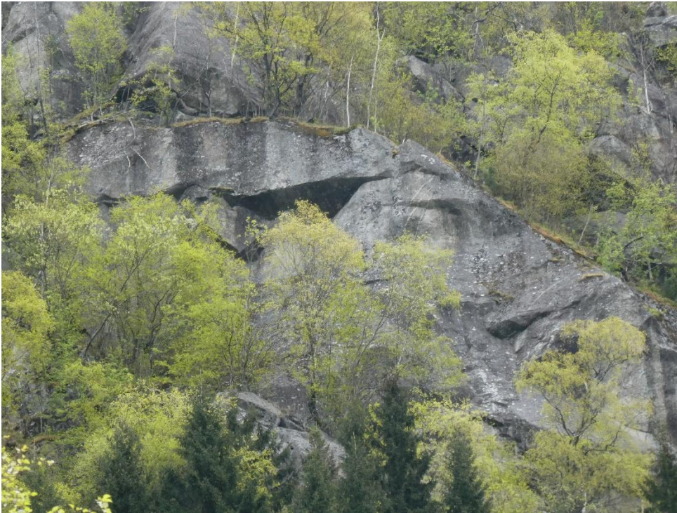
Figur 19 – Oppsprekking i mulig utløsningsområdet like øst for planområdet.
