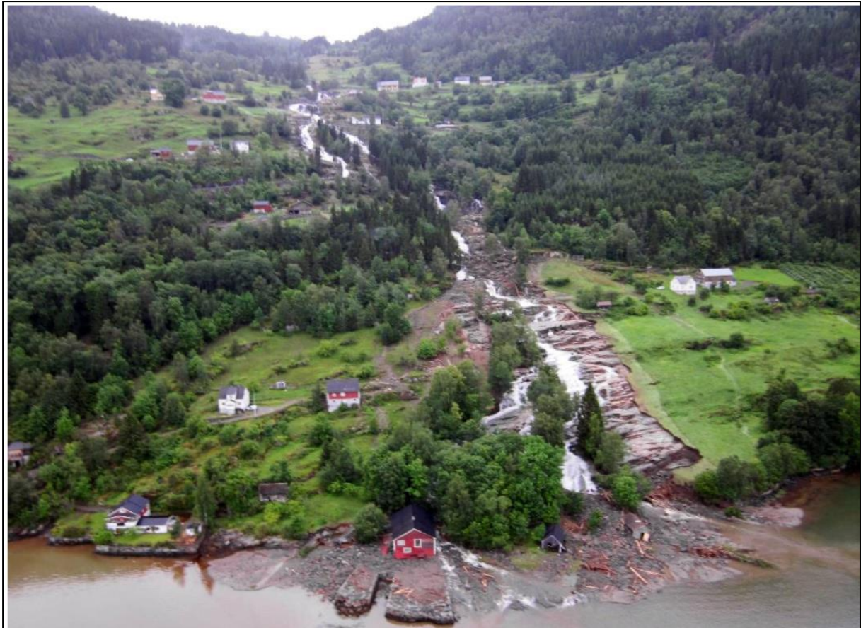
Figur 25: Bilete viser øydeleggingane etter flaumen i elva Steindøla, om lag 1 km nordaust for kartlagd område. Bilete tatt av NVE.
