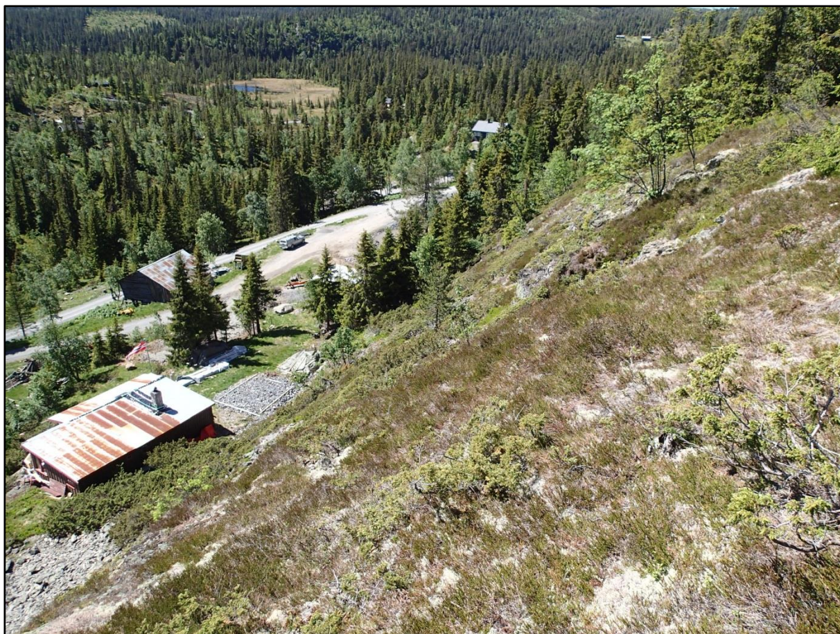
Figur 20 Hytta med terrenget ovenfor. Bildet er tatt mot vest.
