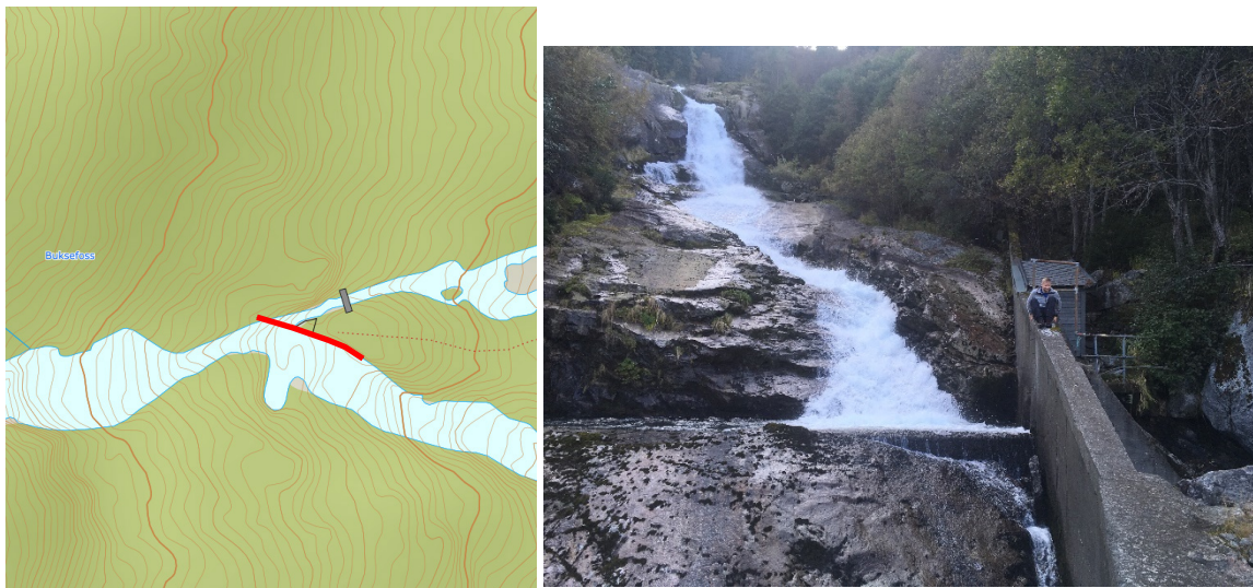
Figur 3-8 Mur som er etablert for å kontrollere vanninnløpet mot vannbassenget som forsyner vann til industrianlegget på Eitrheimsneset.
