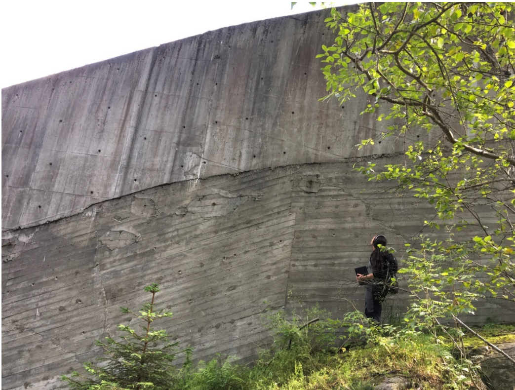
Figur 3-4. Betongvegg. Nedre del bygget i 1978, øvre del bygget på i 1993.
