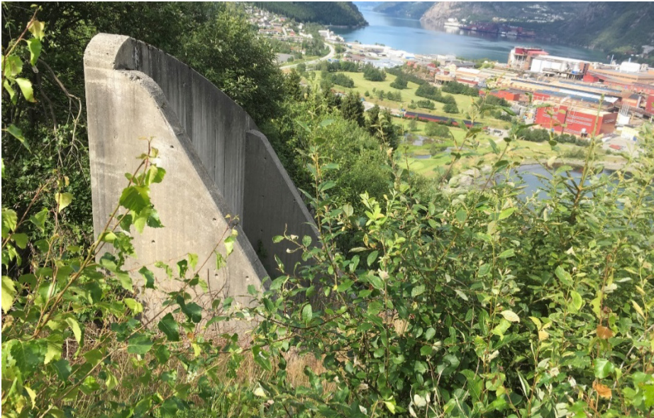
Figur 3-6. Betongvegg, eksisterende tiltak. Nedre del av betongveggen er ikke bygget på etter 1978, slik som de øvre betongveggene.
