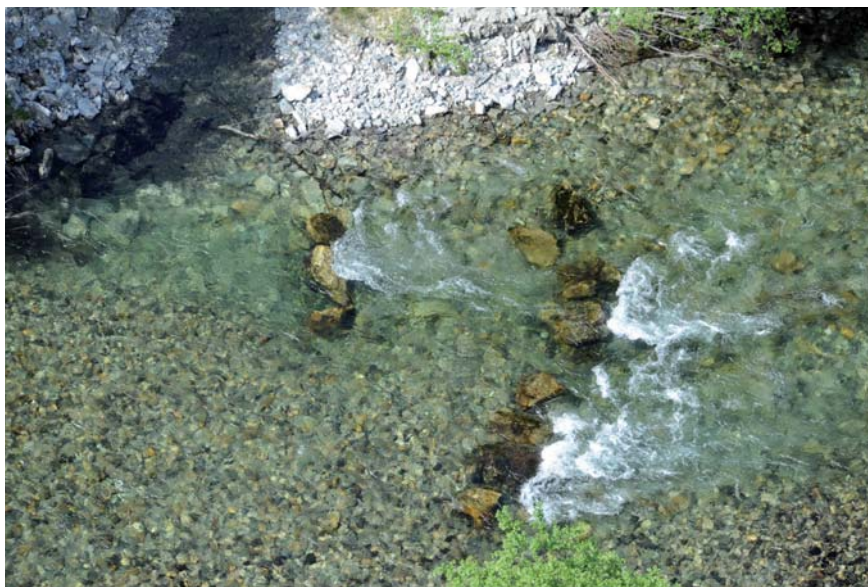
Figur 8.15 Steingruppeutlegging langs kanalisert elvestrekning i Bognelva, Alta. Foto: Gunnar Kristiansen.
