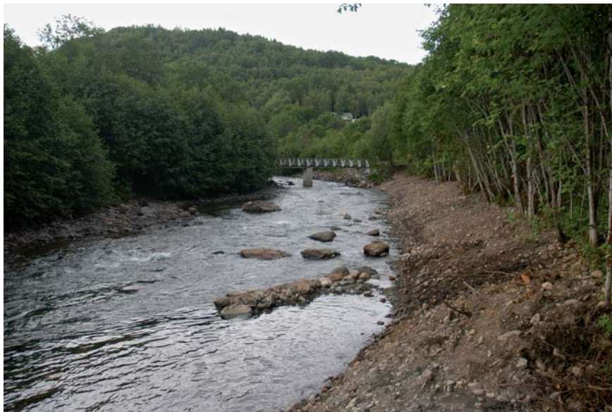
Figur 8.14 Steingrupper ved ombygd sikringsanlegg i Elvegårdselva, Narvik. Foto: Knut Aune Hoseth.
