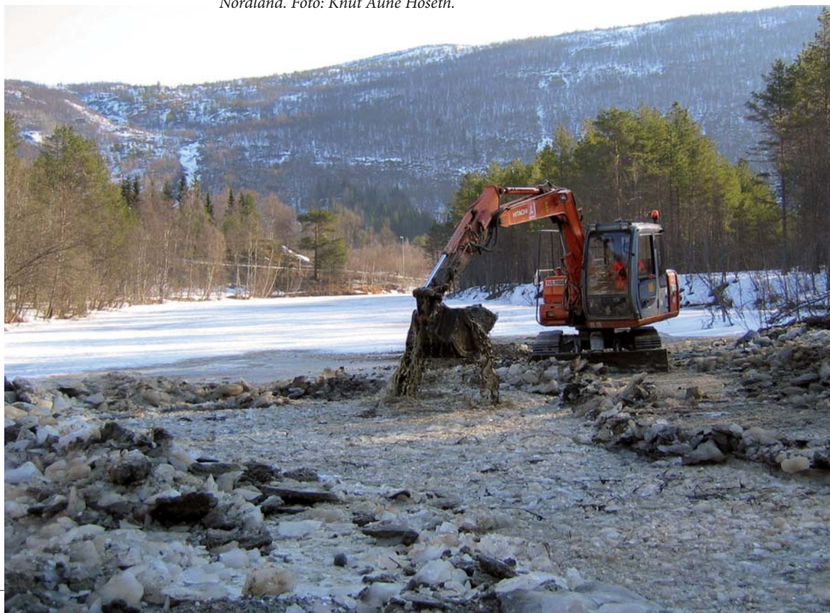
Figur 3.24. Opprenskingsarbeid fra is langs gjengrodd strekning ved Lakselva i Beisfjord, Nordland. Foto: Knut Aune Hoseth.
