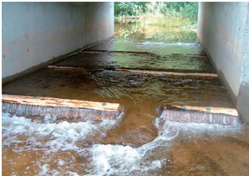
Figur 10.21 Terskelkonstruksjoner i Bleiknesåga, Saltdal. Foto: Knut Aune Hoseth, NVE.
