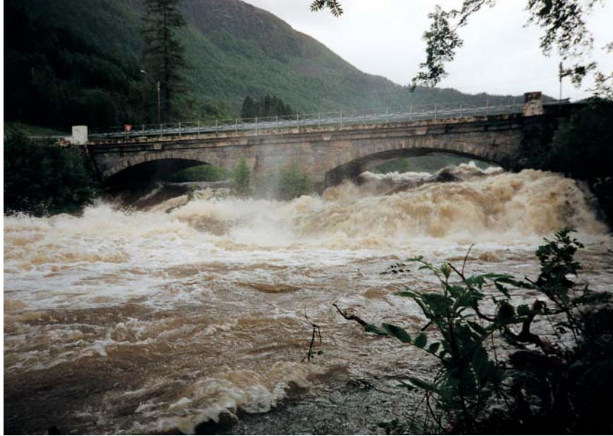
Figur 4.17. Ålvundfossen i flom, Surnadal i Møre og Romsdal. Brua har trange åpninger.
