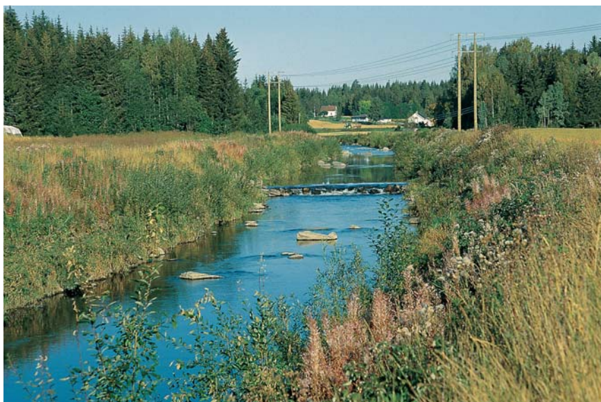
Figur 8.2 Terskel og steingrupper langs kanalisert elvestrekning i Lena. Foto: Jan Henning LAbée-Lund Buner.
