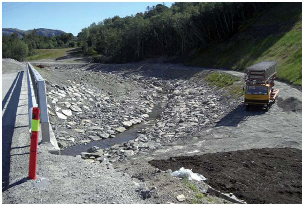
Figur 6.6 Sikring mot erosjon og skred i Lauvsneselva, Flatanger. Foto: Vebjørn Opdahl, NVE.
