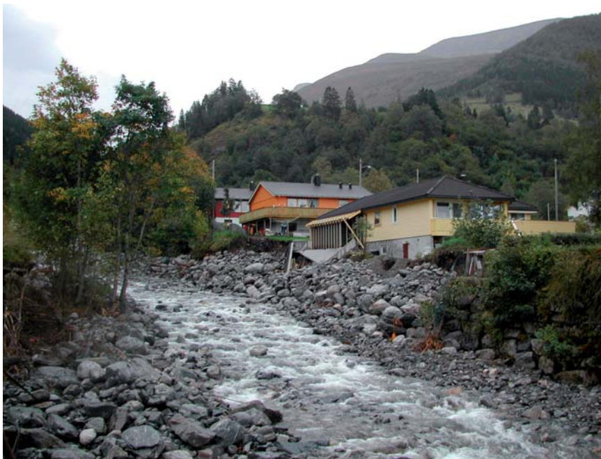
Figur 5.55 a og b. Flomskredvifte i Liadalen i Ørsta og masser etter flomskred høsten 2003. Flere hus og to bruer ble skadet. Foto: NVE.
