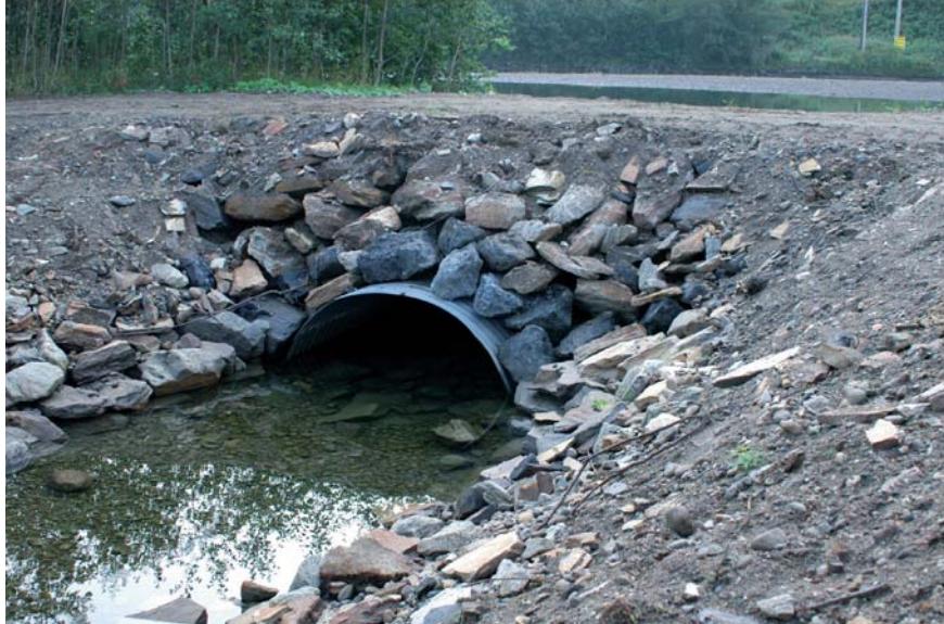
Figur 10.20 Hvelvkulvert som ivaretar fiskeoppgang. Foto: Knut Aune Hoseth, NVE.
