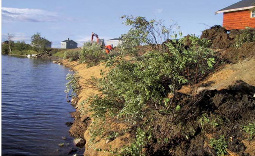
Figur 7.6 Bruk av kokosmatter med påføring av vierkratt fra omkringliggende terreng som erosjonssikringstiltak langs Iesjohka ved Nedre Mollisjok. Foto: Gunnar Pedersen.
