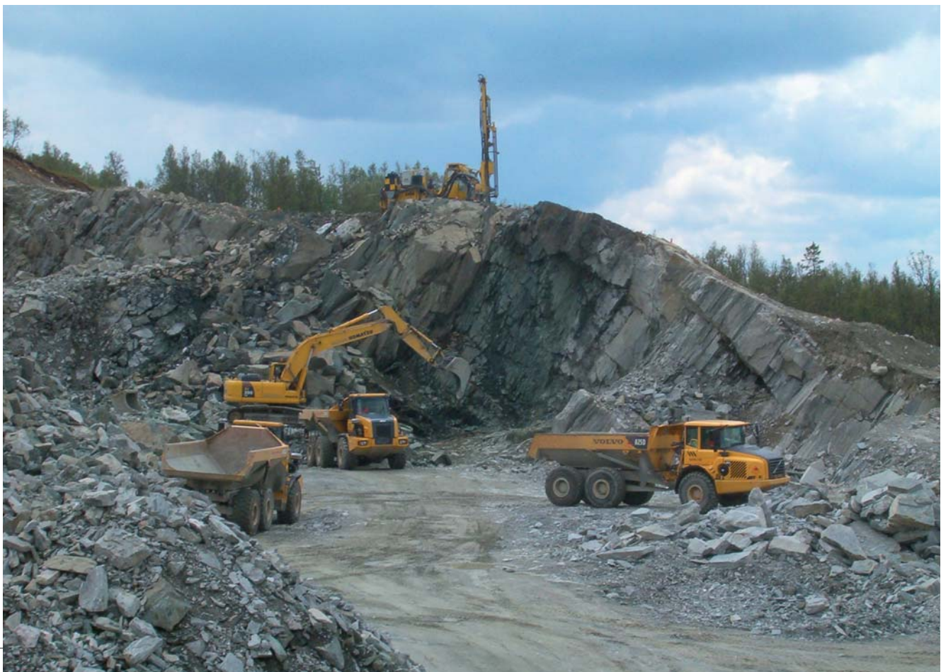
Figur 9.1 Steinbrudd med borerigg, lastemaskin og transportutstyr. Vinje kommune, Telemark. Foto: Kjell Sørensen.
