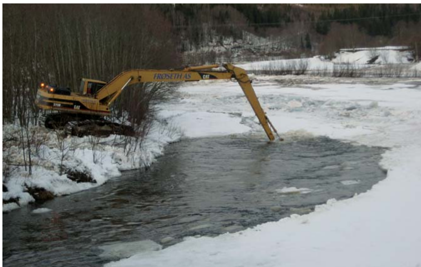
Figur 3.15. Gravemaskin løsner isdam i Helgåa, Nord Trøndelag. Foto: Torger Wisth.
