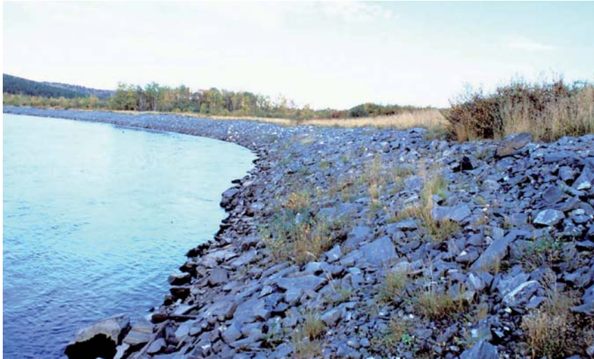
Figur 7.5. Karasjohka ved Jeambealesnjarg før og etter miljøtiltak. Bildene viser vegetasjons-etablering med naturlig vegetasjon. Vekstmasser er tilført og vierbusker og -stiklinger er plantet ut. Foto: Gunnar Kristiansen.
