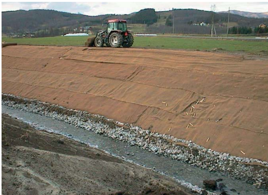
Figur 7.7. Bruk av kokosmatter for sikring av en trang jordbrukskanal i Ballangen. Nedre og mest erosjonsutsatte del er forsterket med steinsikring. Foto: Knut Aune Hoseth.
