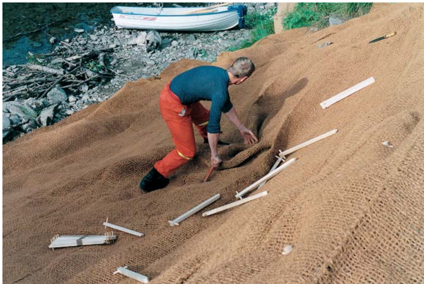
Figur 9.4 Utlegging av kokosmatter i Reisaelva. Foto: NVE.
