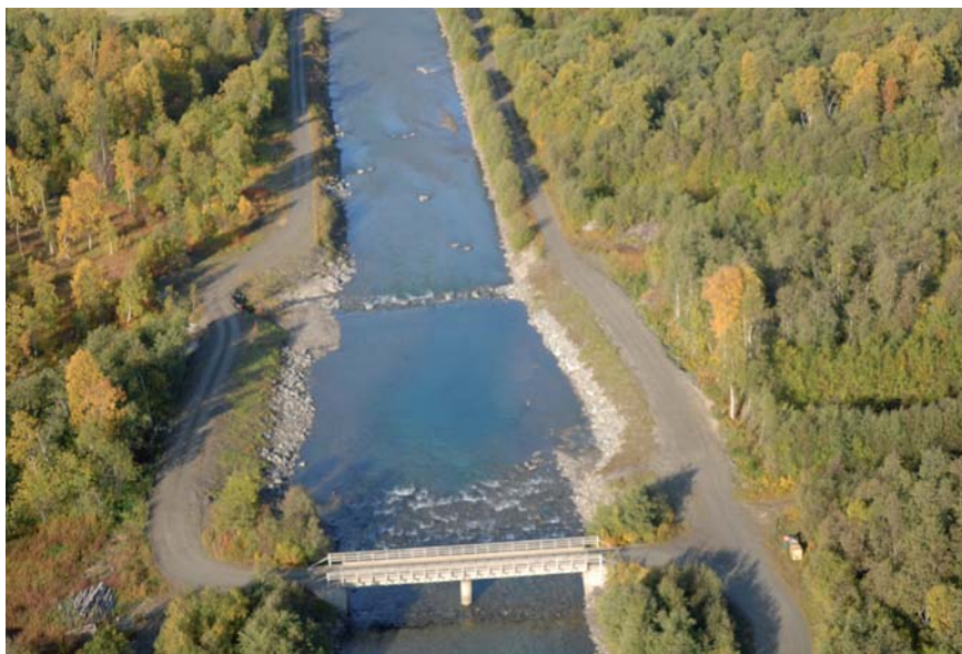
Figur 8.10 Kanalisert elvestrekning med terskel nedenfor brua i Salangselva ved Bones, Bardu. Elveprofilen er utvidet nedenfor terskelen og det er bygd en ny mindre terskel nedenfor kulpen for å hindre bunnsenkning. Lenger ned ses utlagte steingrupper. Foto: Knut Aune Hoseth.
