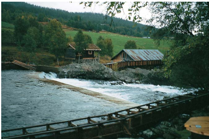
Figur 8.1 Betongterskel ved Atnosen, Hedmark. Foto: NVE.
