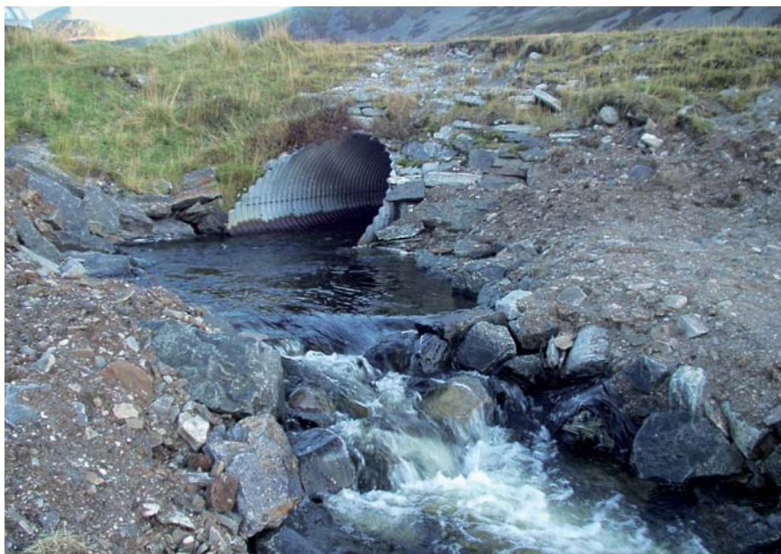
Figur 10.19 Utbedret vandringshinder ved terskelbygging i Risvågvasstraget, Hasvik. Foto: Knut Aune Hoseth, NVE og Geir Johansen.
