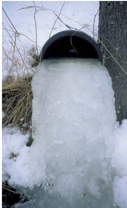
Figur 3.12. Svellis i stikkrenne. Foto: Knut Aune Hoseth.
