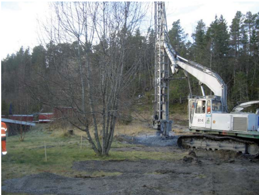
Figur 6.33 Kalk/sementpeling etter skredet i Kattmarka i Namson Her ble det brukt kalk for å stabilisere overflaten av rasmassene for å kunne lage anleggsvei inn i området. Det er også brukt kalk til å stabilisere massene i dybden og sikre mot nye skred i område. Foto Vebjørn Opdahl, NVE.
