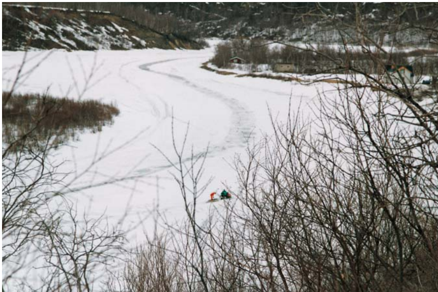
Figur 3.20. Sandstrøing for å åpne råk i Neidenelva, Finnmark. Foto: Knut Aune Hoseth.
