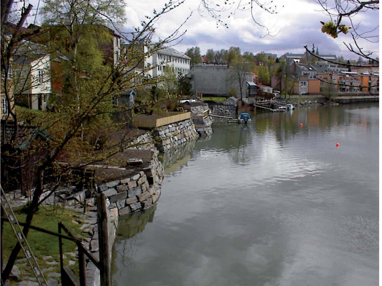
Figur 6.8 Restaurert tørrmur ved Bakklandet i Trondheim sikrer elvekant og bebyggelse mot erosjon og skred. Foto: NVE.
