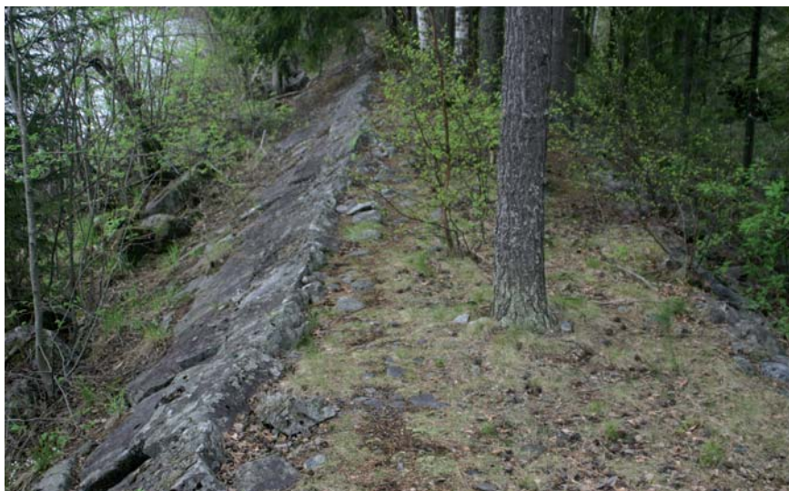
Figur 6.3 Gammel skådam, Dokka. Forseggjort flomverk kledd utvendig med flate steinheller. Foto: Arne Hamarsland NVE.
