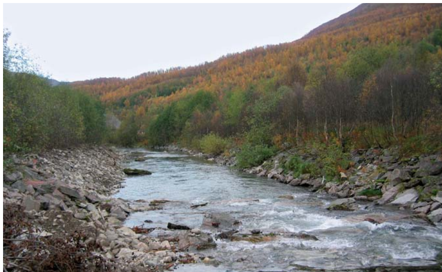
Figur 7.11 Fra Bognelva i Alta hvor erosjonssikringsanlegget langs venstre bredd er fjernet langs denne strekningen. Deler av steinfyllingen er lagt ut i elva for å variere strømningmønsteret og gi et mer naturlig vassdragsmiljø. Siste bilde er tatt like etter gjennomføringen. Foto: Knut Aune Hoseth og Anders Bjordal.
