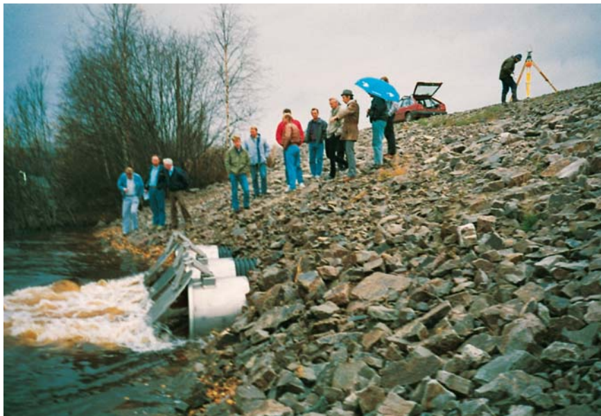
Figur 6.27 Drenasjerør med klappeventiler ved flomverk i Heradsbygd, Hedmark. Foto NVE.
