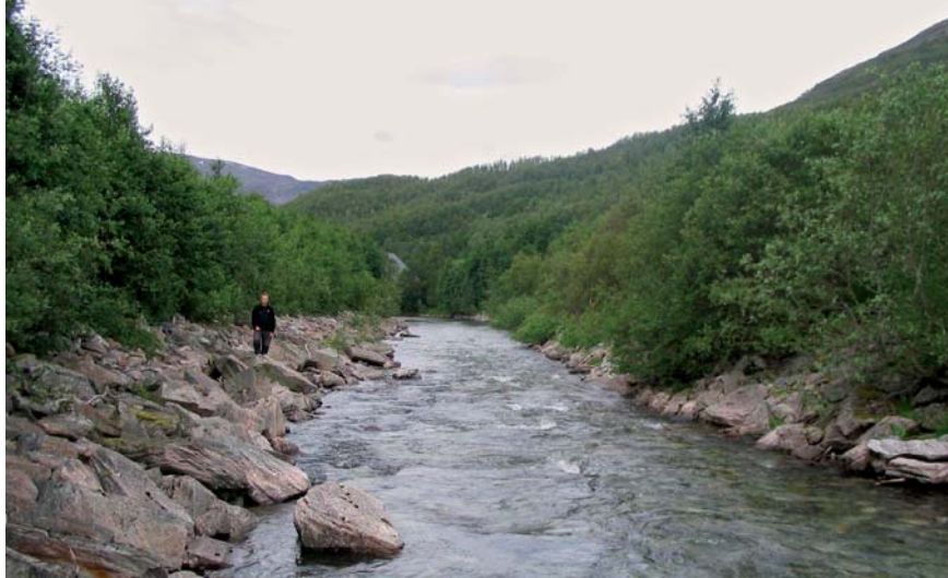
Figur 7.11 Fra Bognelva i Alta hvor erosjonssikringsanlegget langs venstre bredd er fjernet langs denne strekningen. Deler av steinfyllingen er lagt ut i elva for å variere strømningmønsteret og gi et mer naturlig vassdragsmiljø. Siste bilde er tatt like etter gjennomføringen. Foto: Knut Aune Hoseth og Anders Bjordal.
