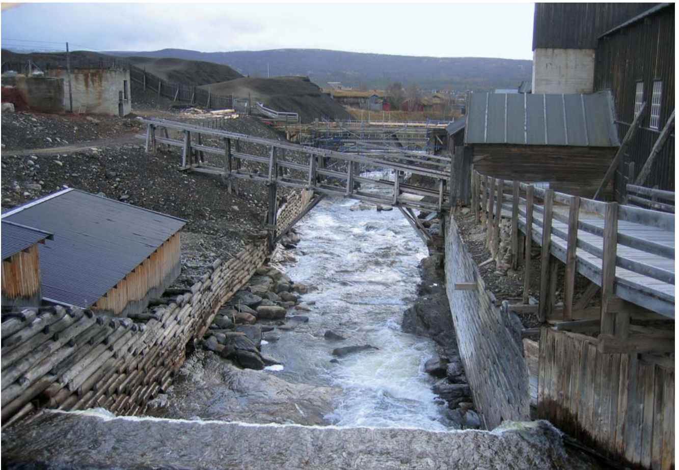
Figur 6.2 Restaurerte tømmerkister og murer sikrer slagghauger og elvebredder mot Hitterelva i Roros. Foto: Einar Sæterbø, NVE.
