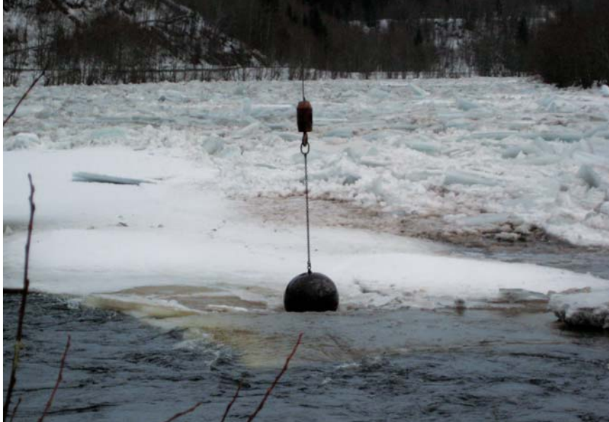
Figur 3.16. Mobilkran med kule løsner isdam i Helgåa, Nord Trøndelag. Foto: Torger Wisth.
