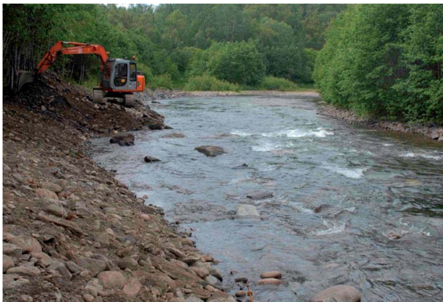
Figur 7.8. Tilbakeføring av erosjonssikringsanlegg i Elvegårdselva i Bjerkvik. Foto: Gunnar Kristiansen.
