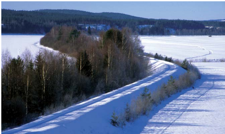
Figur 6.25 Oversiktsbilde av flomverk ved Glomma (Kirkenær). Foto Arne Hamarsland, NVE.
