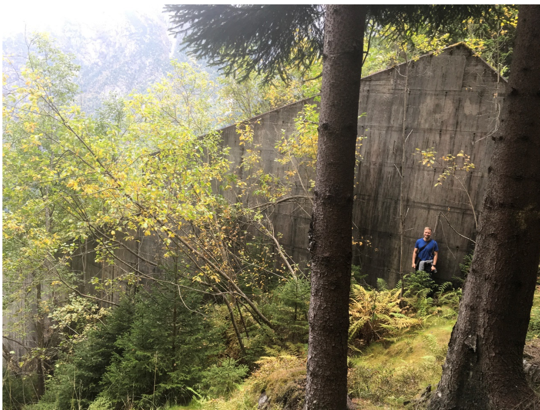
Figur 3-6. Betongvegg over boligfelt ved Kalvanes, bygget etter skredvinteren i 1993.
