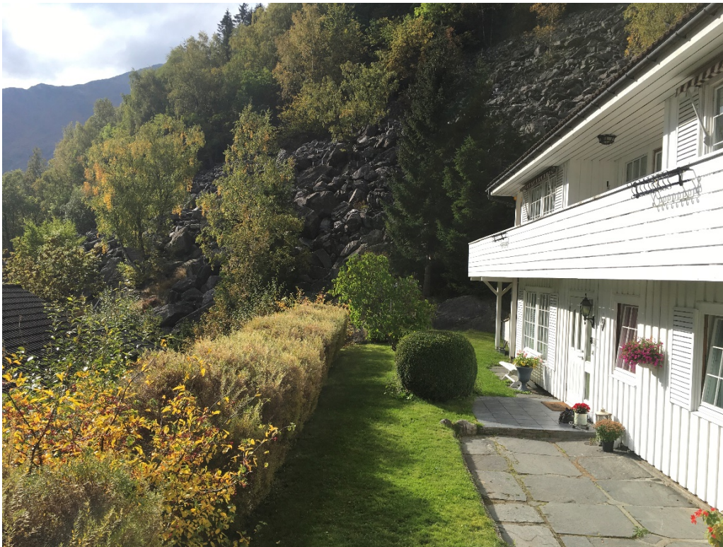
Figur 5-4. Ura kun få meter unna eksisterende bebyggelse ved Eitrheim.
