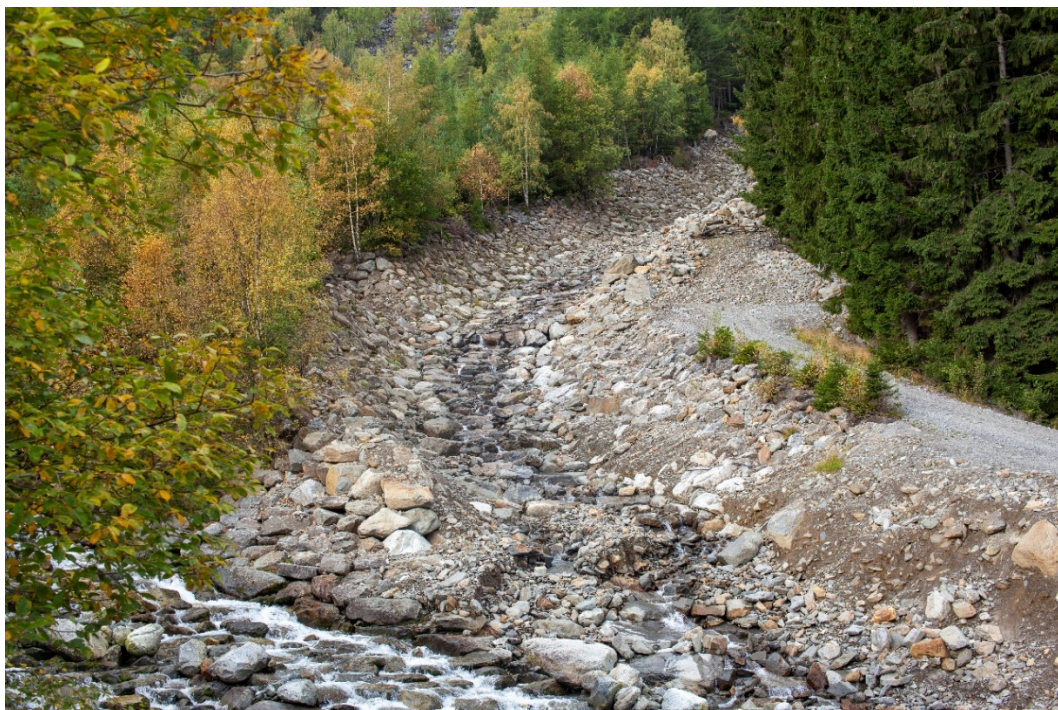
Figur 3-8. Plastring langs Skredbekken.
