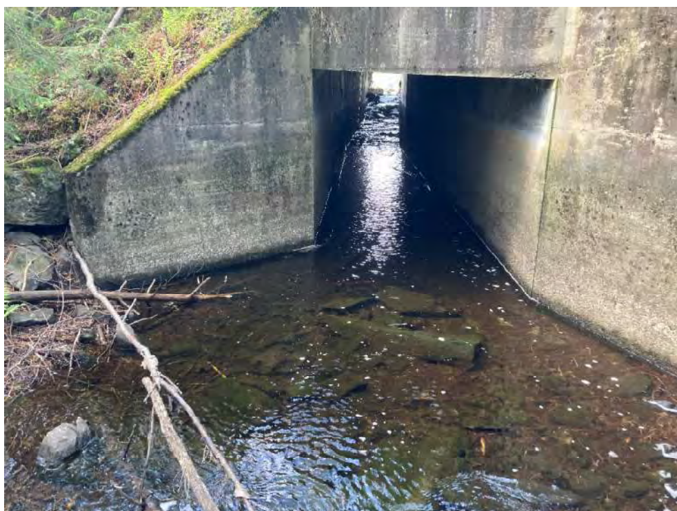
Figur 16 Kulvert under fv 47 sett nedenfra
