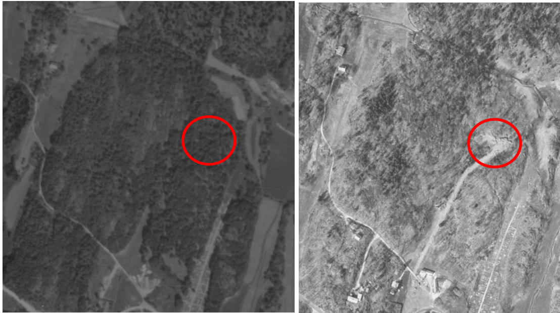
Figur 7-1. Flyfoto fra 1946 (t.v) og 1968 (t.h). På bildet fra 1968 er det tydelig at transformatorstasjonen er under bygging, mens det på begge bildene kommer fram at området lå like i de nærliggende skogene til jordbruksarealene i Arendal. Kilde: norgebilder.no.
