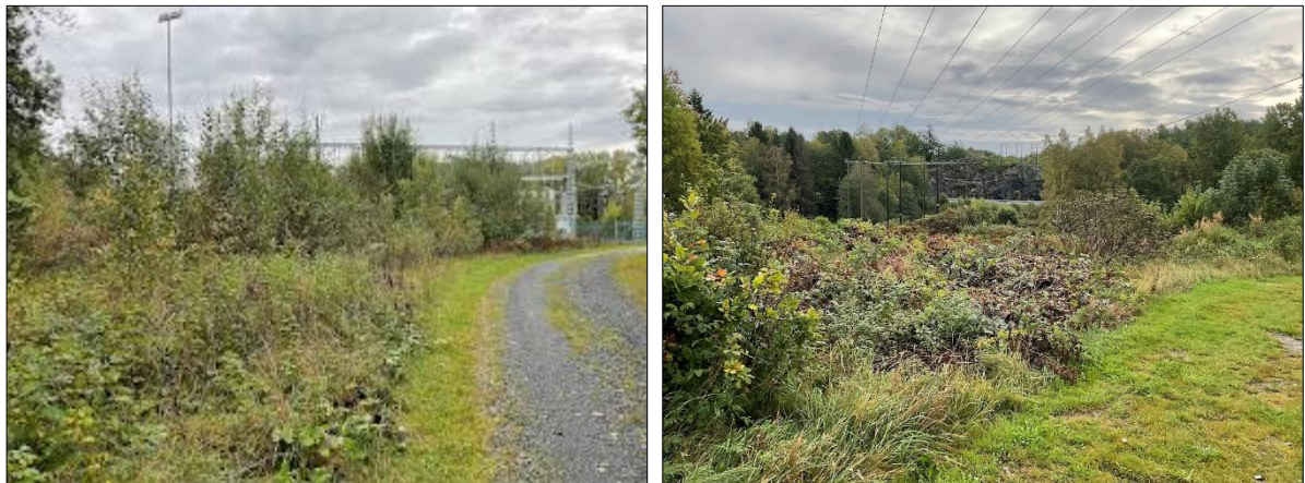
Figur 6-3. Like sør for trafostasjonen og under kraftlinjene er skogen holdt nede (Foto: Rambøll).
