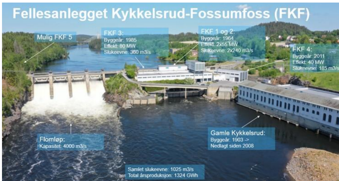
Figur 1. Eksisterende kraftverk med overløp gjennom dammen. FKF 5 er planlagt på vestsiden av elva.
