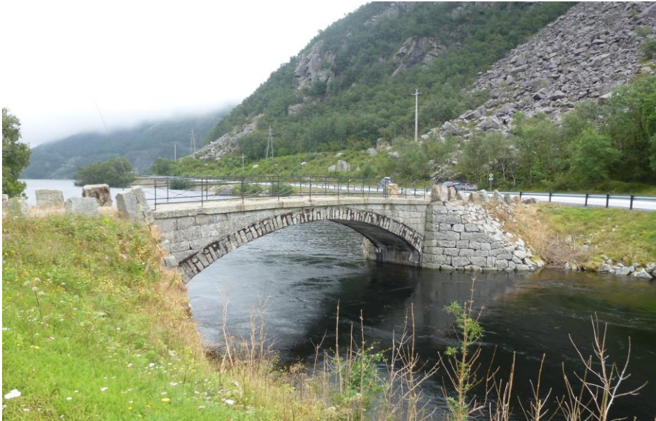
Figur 4-26. Rage bru mot vest. Eksisterende ledningsnett som skal saneres i bakgrunnen. Foto: V. Berge, Multiconsult AS.
