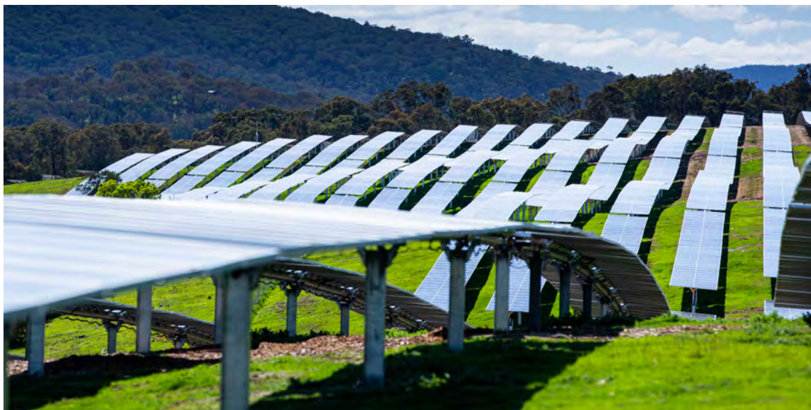
Figur 4: Illustrasjonsfoto én-akse systemet NX-Horizon -XTR levert av selskapet Nextracker. Foto fra Nextracker.
