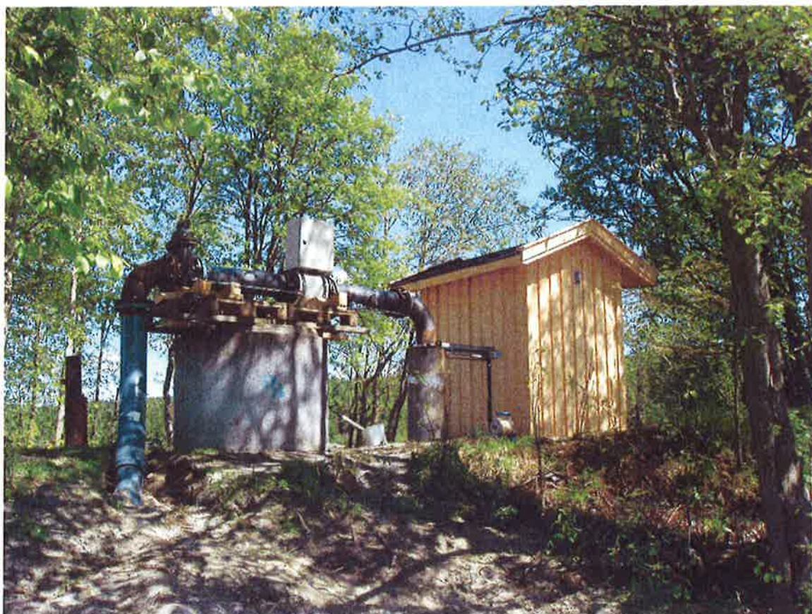
Figur 1. Prøvepumpingsarrangement ved ny rørbrønn (Rb3).
