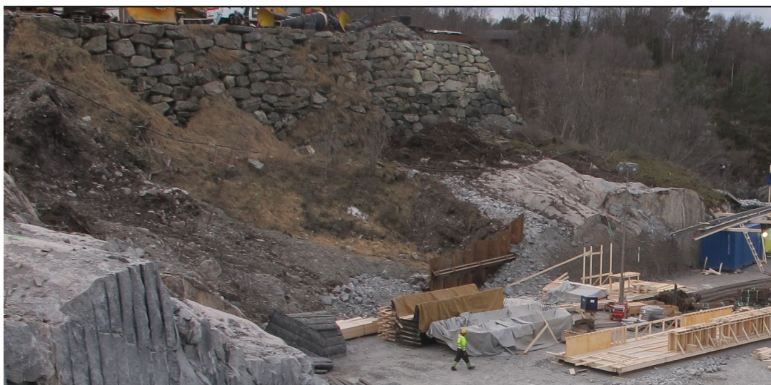
Figur 4: bilde viser spunt som ble slått ned for å stabilisere resterende leire opp mot tørrmur i 2013 ved bygging av landområdet ved Oppedal fergekai.
