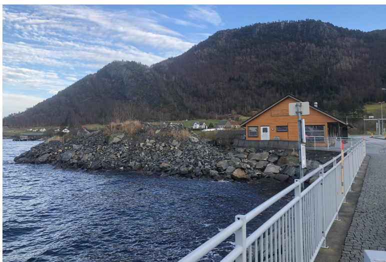
Figur 5: Bilde er tatt fra område mellom dagens fergekai og servicebygget (gult bygg). Liggekai skal plasseres nord for servicebygget. Borpunkt 34 og 35 er tatt på land ved gjerdet (se røde pinner festet på gjerdet).
