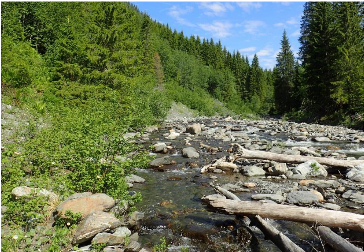
Figur 5. Bilde av Dørja like oppstrøms området der bunnlastsperren skal bygges.
