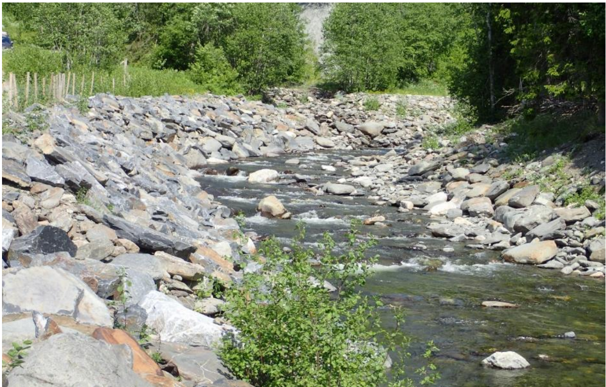
Figur 7. Dørja nedstrøms samløp med Gryta, der elva er delvis erosjonssikret på vestsiden.
