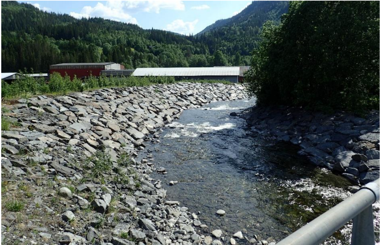
Figur 6. Nedre del av Dørja ved Helleberg, der elva er kanalisert og erosjonssikret.
