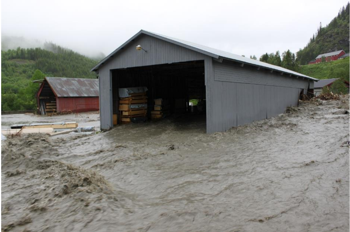
Figur 3. Bilde av lagerbygning ved Helleberg Sag. Dørja flommer gjennom i bakgrunnen.
