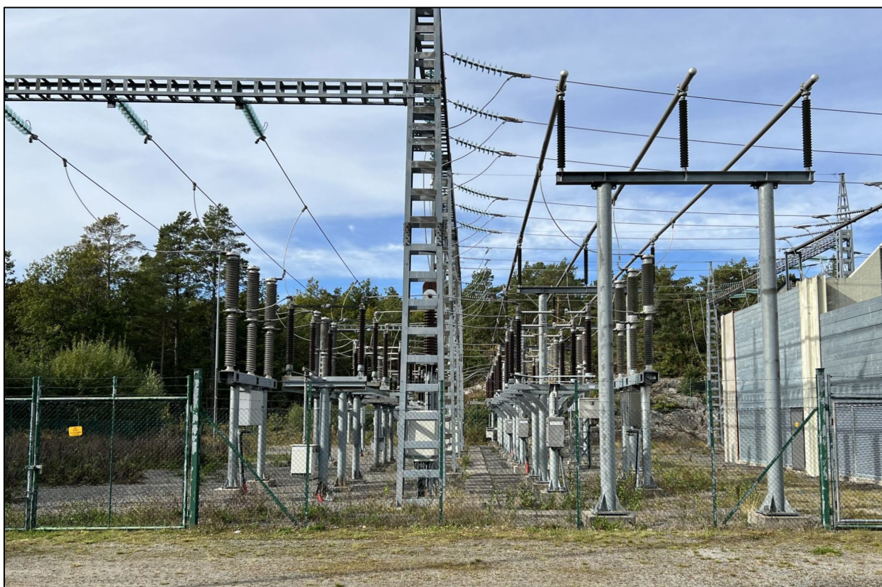
Figur 5: 132 kV-koblingsanlegget
