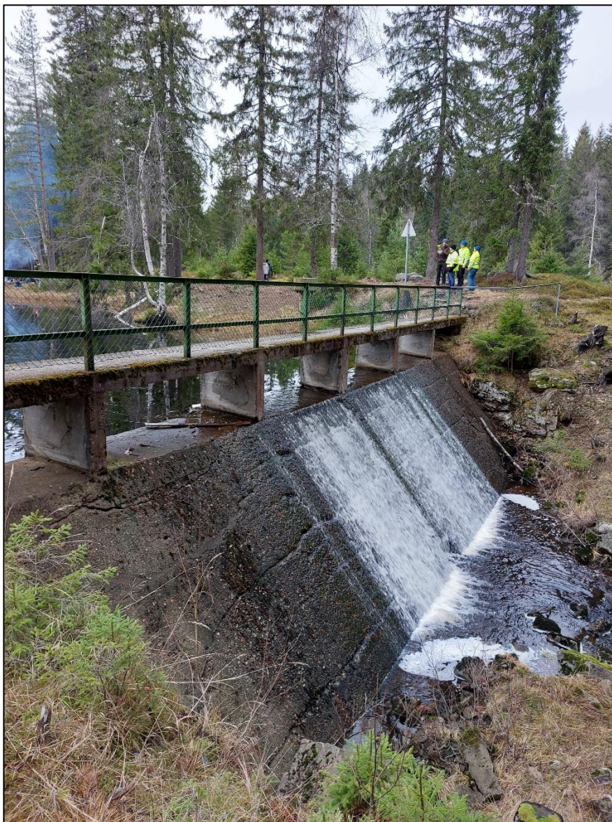
Figur 1-1. Dammen ved Løken som skal rehabiliteres.
