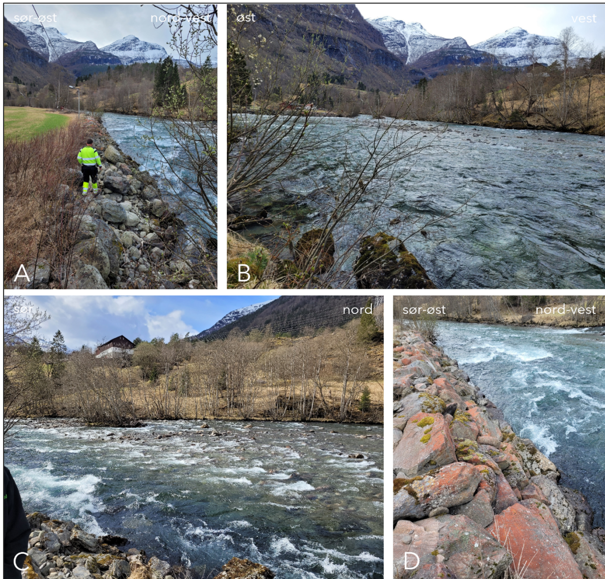
Figur 1-3: Lokasjon Bedehuset, A- øvre del av erosjonssikring. B-Grusbanke oppstrøms, sedimentasjon i midten, djupål mot sidene. C - Djupål presser mot erosjonssikring, øy med vegetasjon på grusbanken vaskes ut. D - nedre del av erosjonssikring, antas å være uten fotstøtte.
