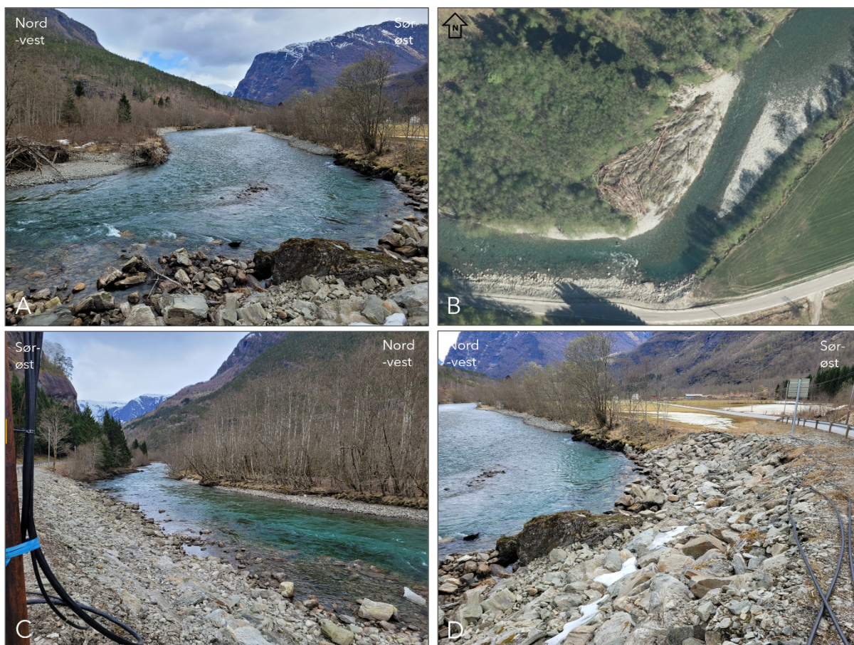
Figur 1-8: bilder fra befaring rundt Sving Lustravegen, A-C, bilde D illustrerer drivgods og sedimentasjon i elveløp, men spesielt i innersving. Uttak av masser fra elveløpet er lagt mot sidene oppstrøms svingen.
