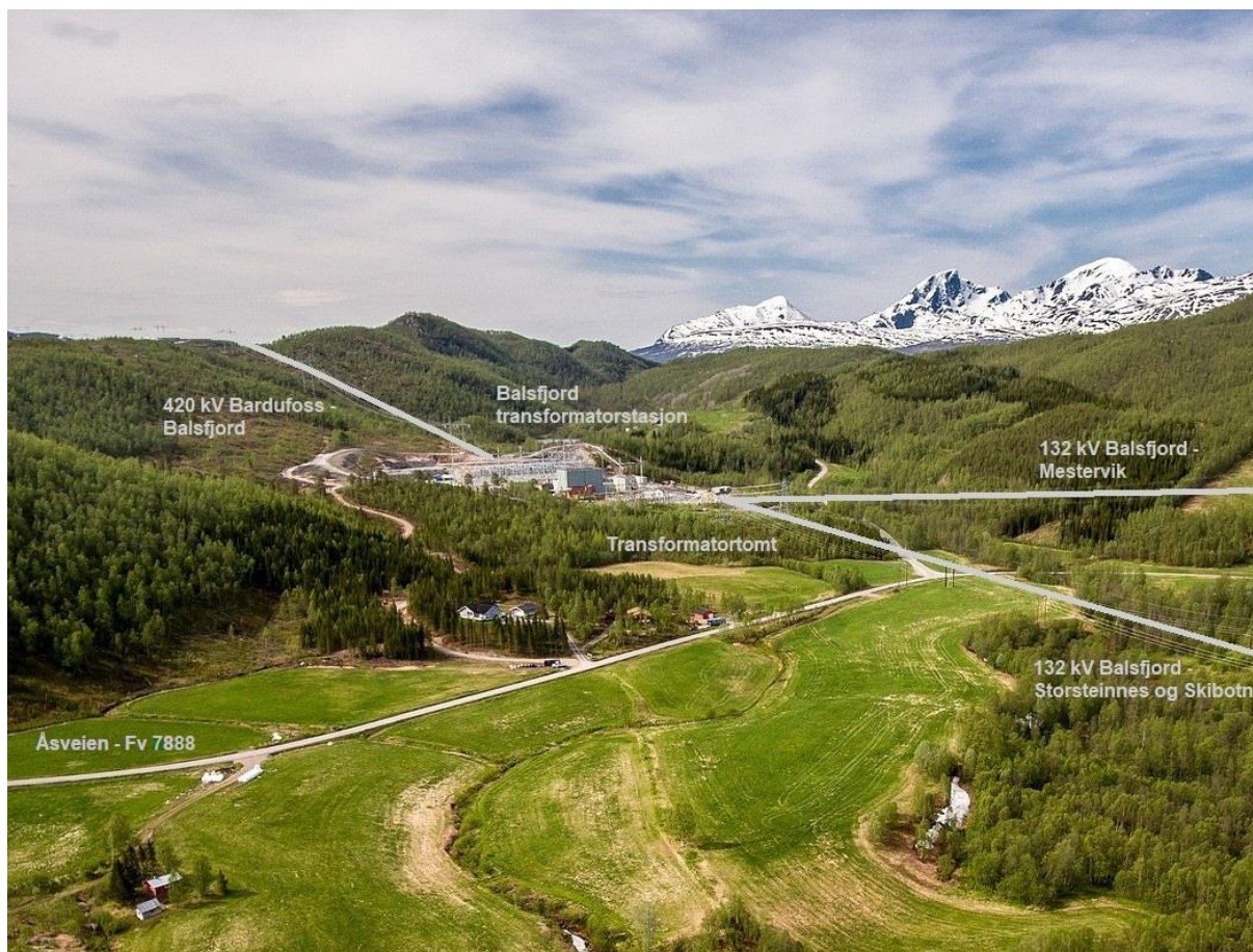
Figur 5 - Bildet viser dagens situasjon med Balsfjord transformatorstasjon og eksisterende kraftlinjer. Bildet er tatt i vest - sør-vestlig retning. 420 kV Ofoten – Skaidi og Kvandal – Balsfjord er etablert i nyere tid og er derfor ikke med på bildet.
