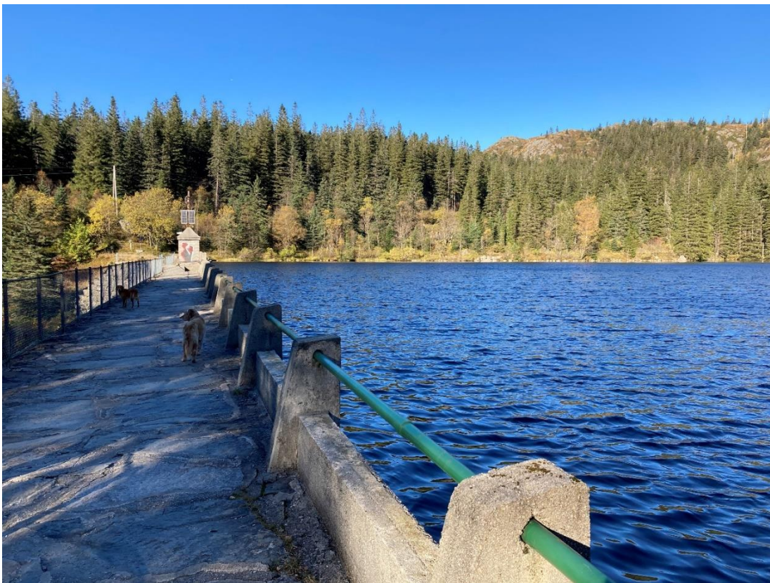
Figur 6: Dagens murdam og vannspeilet.
