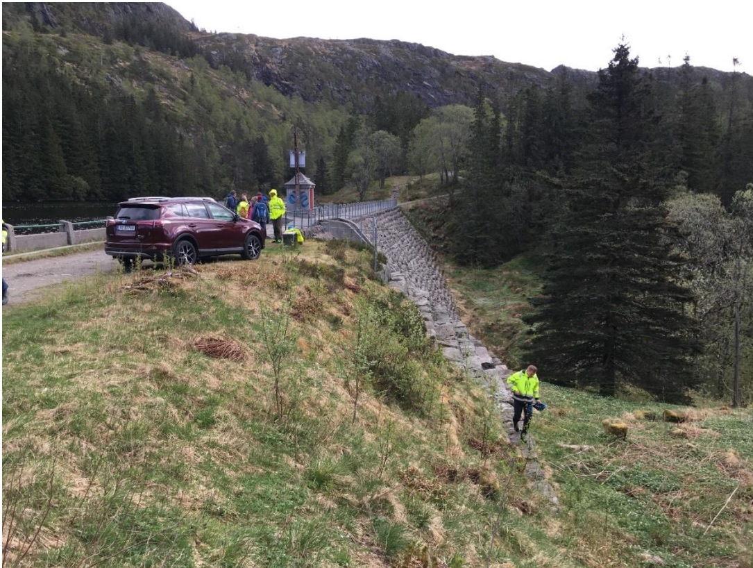
Figur 1: Dagens dam, med jordvoll-delen i forgrunnen.
