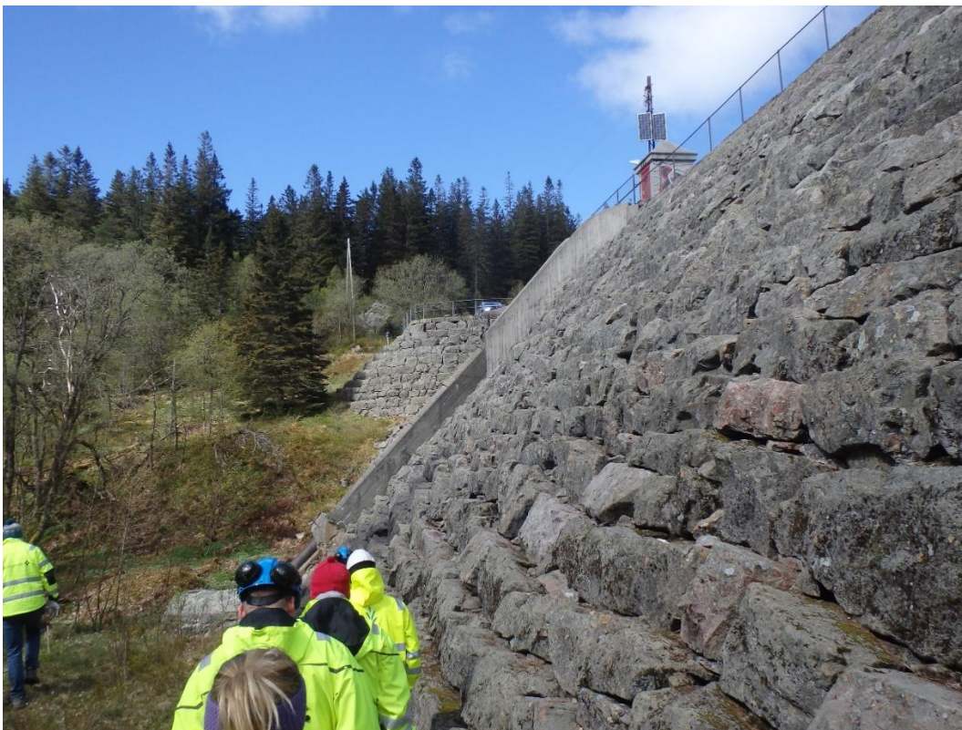
Figur 4: Dagens situasjon. Murdam med overløp midt i bildet.
