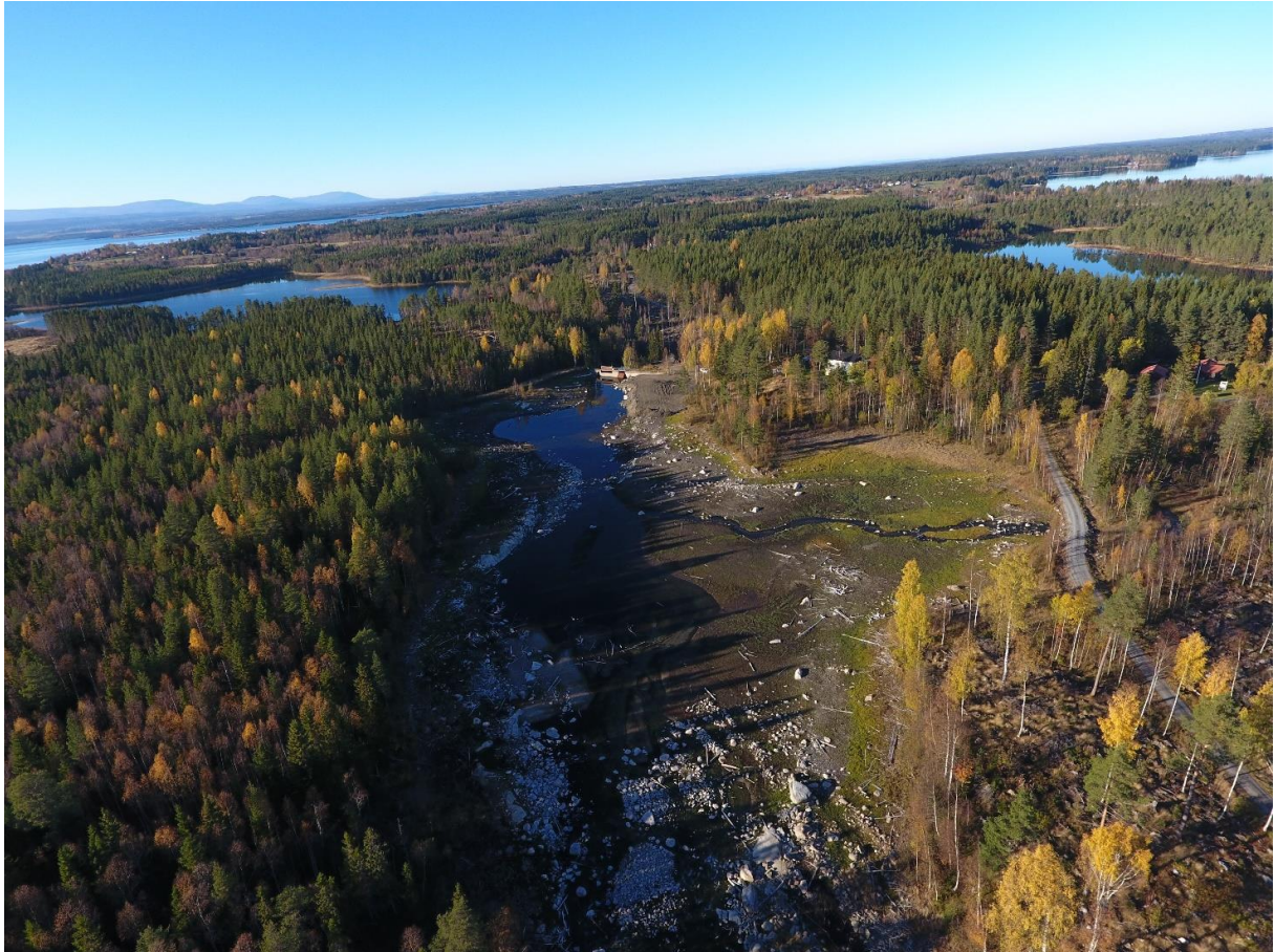
Figur 13: Ävjendammen i Sverige etter nedtapping. Bildet er tatt i samme år som nedtappingen skjedde. Vegetasjonen begynte å etablere seg allerede samme vekstsesong som nedtappingen.
