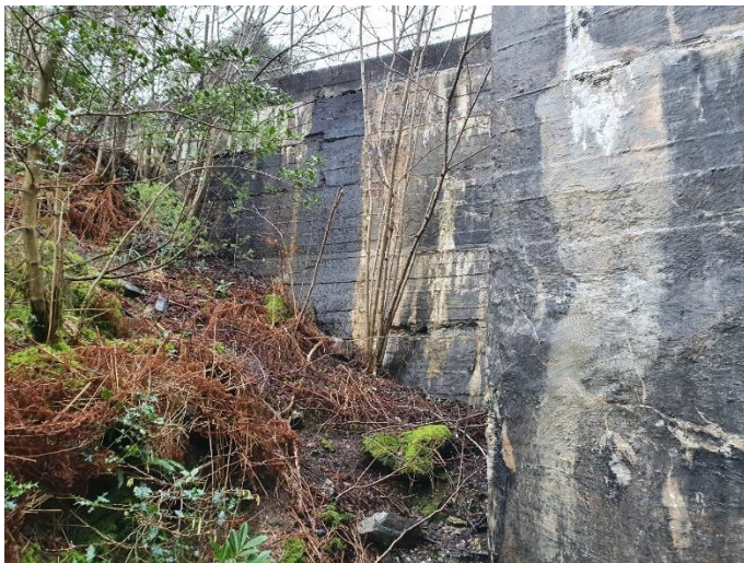
Luftsiden (høyre side)
