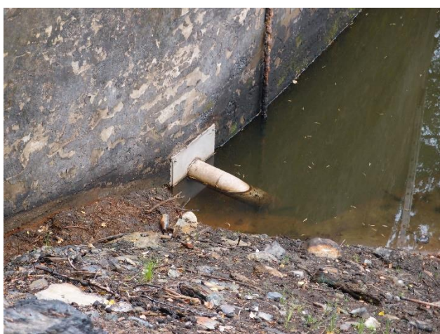
Tapperør montert i kjerneboret hull gjennom dammen
