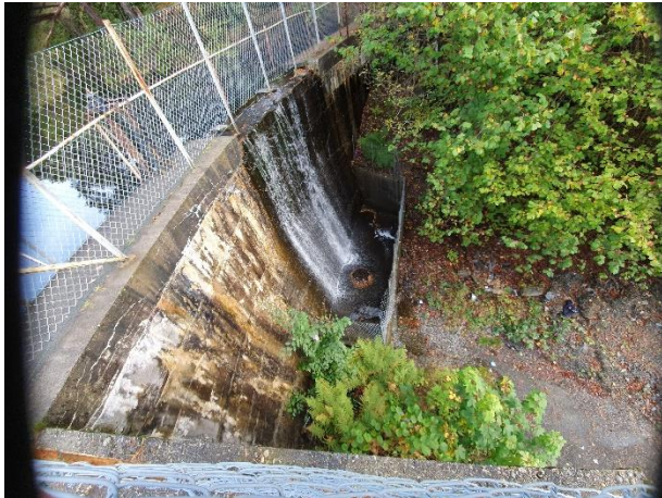
Dammens venstre luftside sett fra toppen av silkammeret
