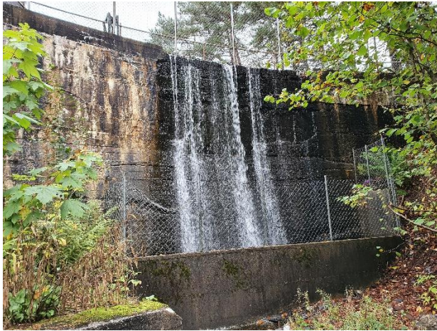
Luftsiden ved flomløpet (venstre side)
