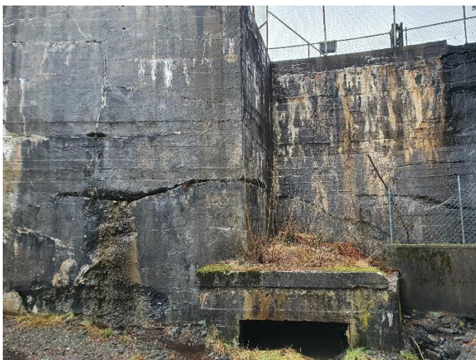
Et ventilkammer/silkammer er bygget sammen med dammen
