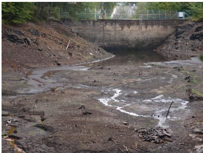
Nedtappet dam sett fra oppstrøms side
