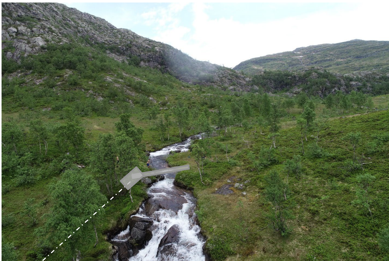
Område for dam og inntak sett fra nedstrauts side. Dam, inntak (grå) og borhol (kvit stipla).
