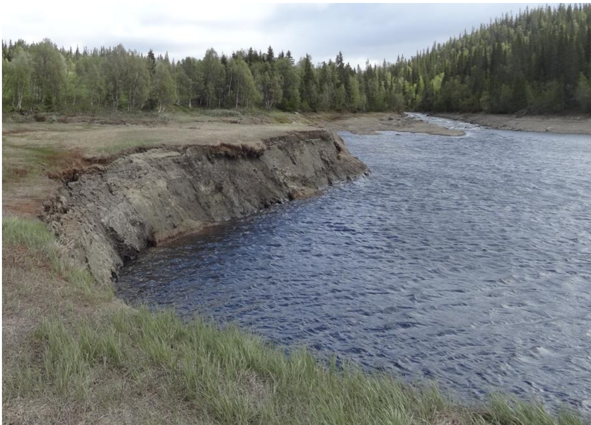
Figur 40: Bilde av erosjonsskader i Nyvika i Limingen. Dette er et av de områdene der erosjonsskadene fremstår som størst. Kilde: NVE.
