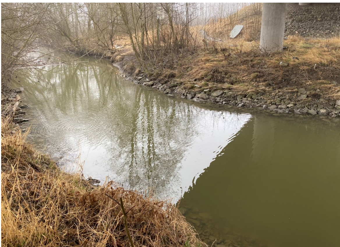
Figur 23: Foto viser erosjonssikring under eksisterende jernbanebru. Bilde er tatt mot sør
