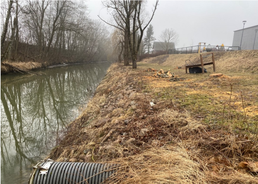
Figur 24: Foto viser erosjonssikring nedenfor nytt boligfeltet. Bilde er tatt fra nordside av elva mot vest.
