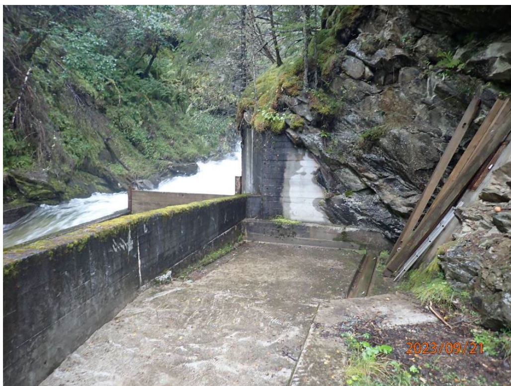
Eksisterende inntak til Vikfalli kraftverk, stasjonen kommer oppe til høyre i bildet
