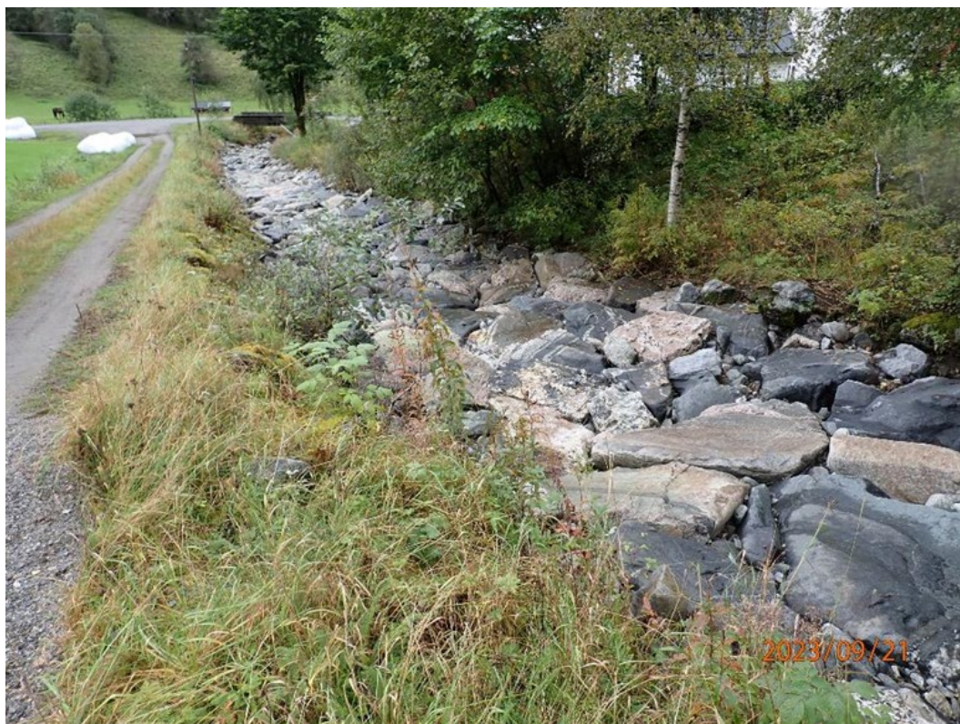
Tura nedstrøms inntaket til Vikfalli (tørrlagt)
