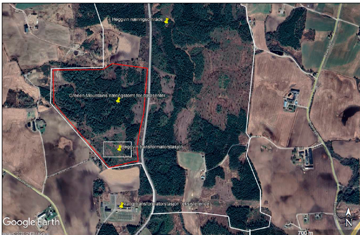
Figur 1: Oversiktsfotoet viser beliggenheten for de omsøkte anleggene. Kilde: Green Mountains søknad av 3. oktober 2023.
