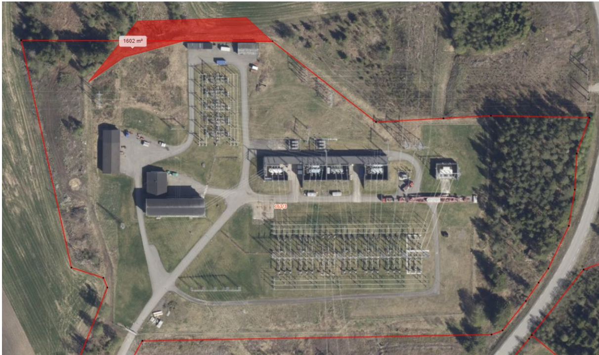
Figur 2: Oversiktsfoto dagens Vang transformatorstasjon med eiendomsgrense og utvidelsen i rødt. Kilde: Elvias søknad av 22. november 2023.
