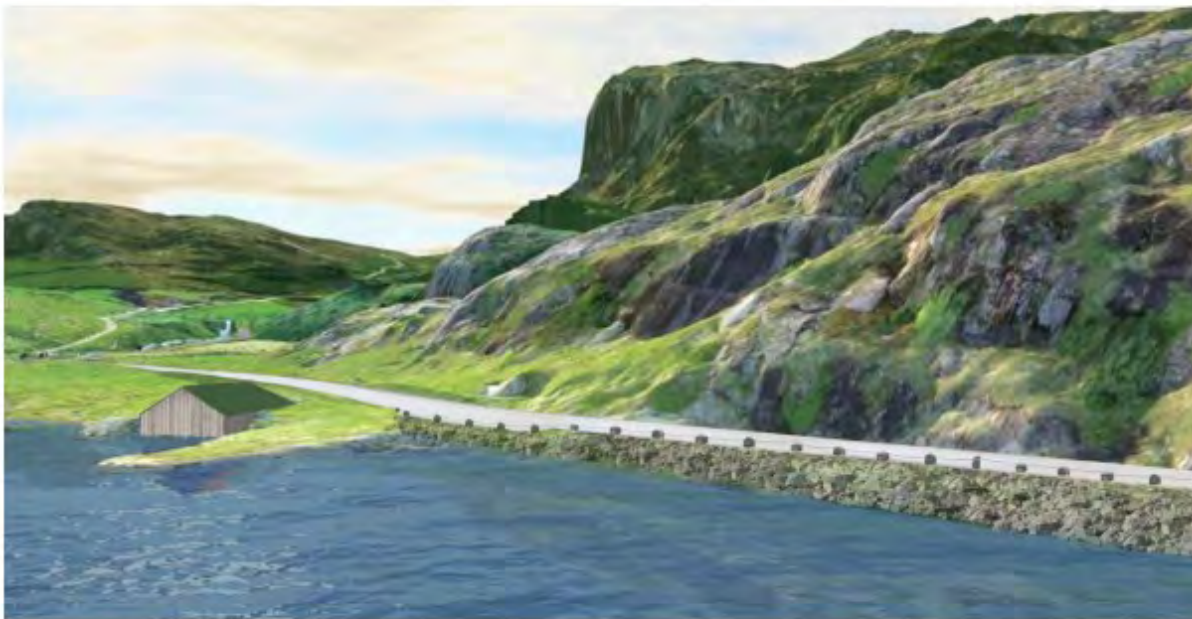
Figur 28: Fylling i Birkelandsvatnet, skråning og eksisterende båthus
