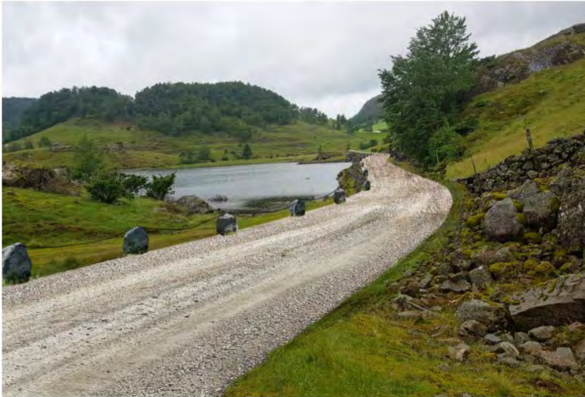
Figur 27: Adkomstveg langs Birkelandsvatn
