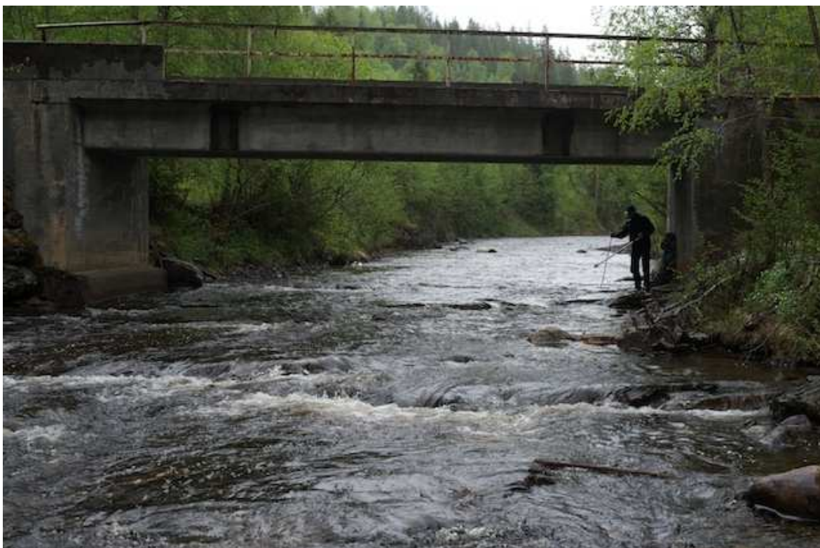
Bru ved nedre del av Leksa sett motstrøms
