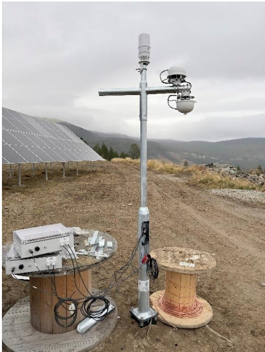
Figur 5-5. Illustrasjon av stativ med meteorologiske instrumenter, under bygging.
