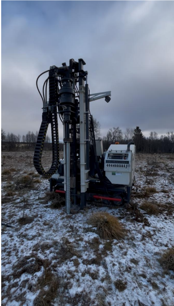
Figur 4-3: Beltegående rigg for jordskruer som ble benyttet under prøvefundamentering
