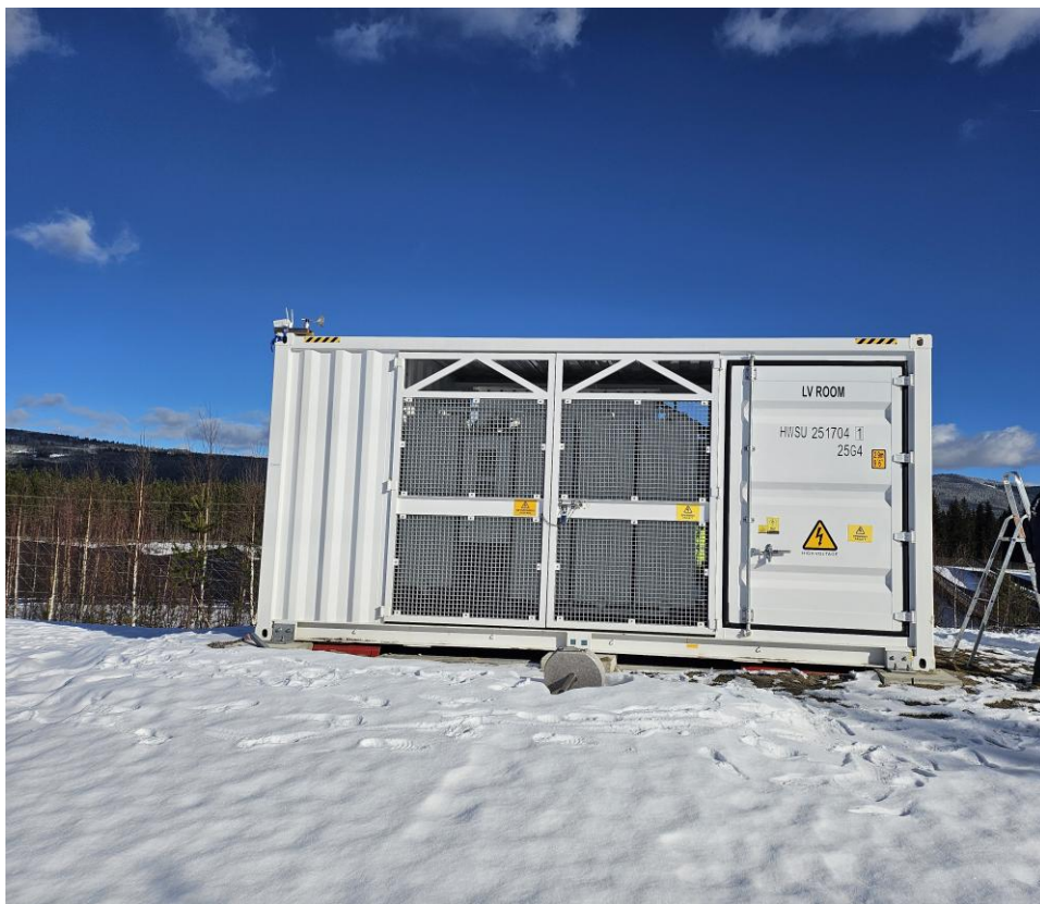
Figur 5-4. Eksempel på transformator utført som container.
