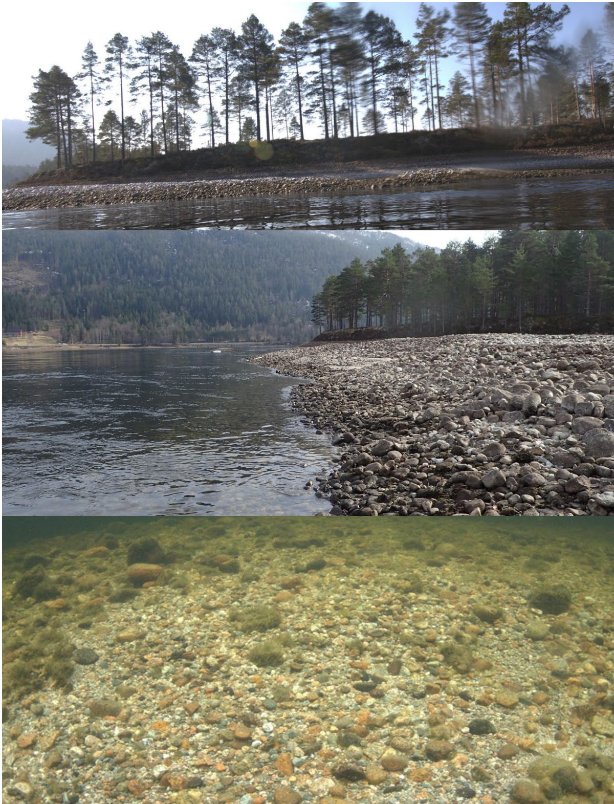
Figur 8. Tiltaksområde 1.2. De to øverste bilde viser grusryggen før den ble senket i 2020. Nederste bilde viser bunnforholdene på deler av vollen etter senkningen hvor det deretter årlig er registrert gytefisk og gytegrøper av bleke. Det planlagte tiltaket vil senke og spre denne grusbanken ytterligere og dermed bidra til å gjøre et større areal tilgjengelig for gyting.
