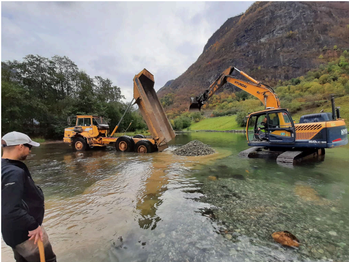
Figur 46. Grusutlegg ved bruk av dumper og gravemaskin i Aurlandselva (foto: NORCE LFI).
