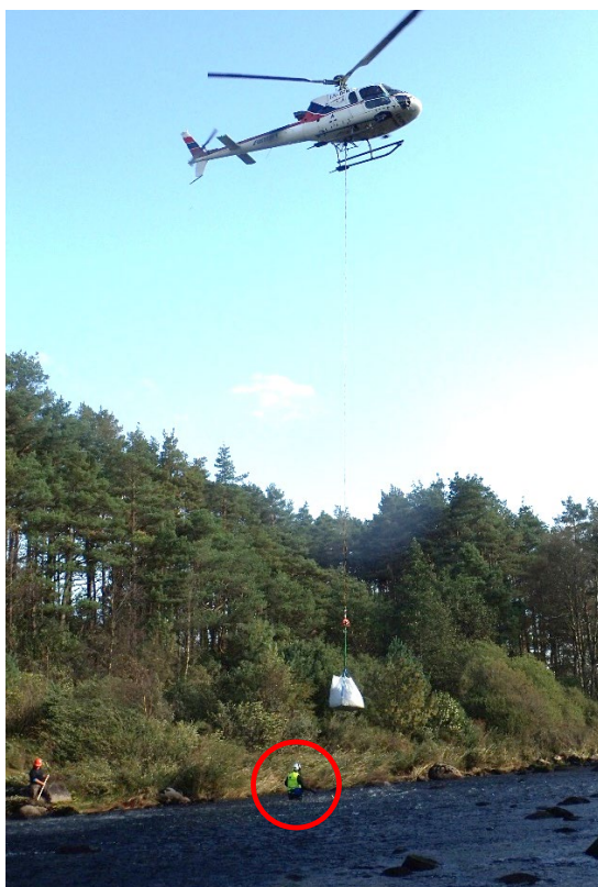
Figur 33. Utlegg av grus med helikopter. Til venstre kan man se utlegg av bigbags i Figgjo, som krever at man har personell i vannet som kutter opp sekkene med kniv og så fordeler grusen. Til høyre vises utlegg av grus ved bruk av tobb i Frøysetvassdraget hvor helikopterpiloten kan slippe grusen på anvist plass uten at personell i vannet må være nær lasten.
