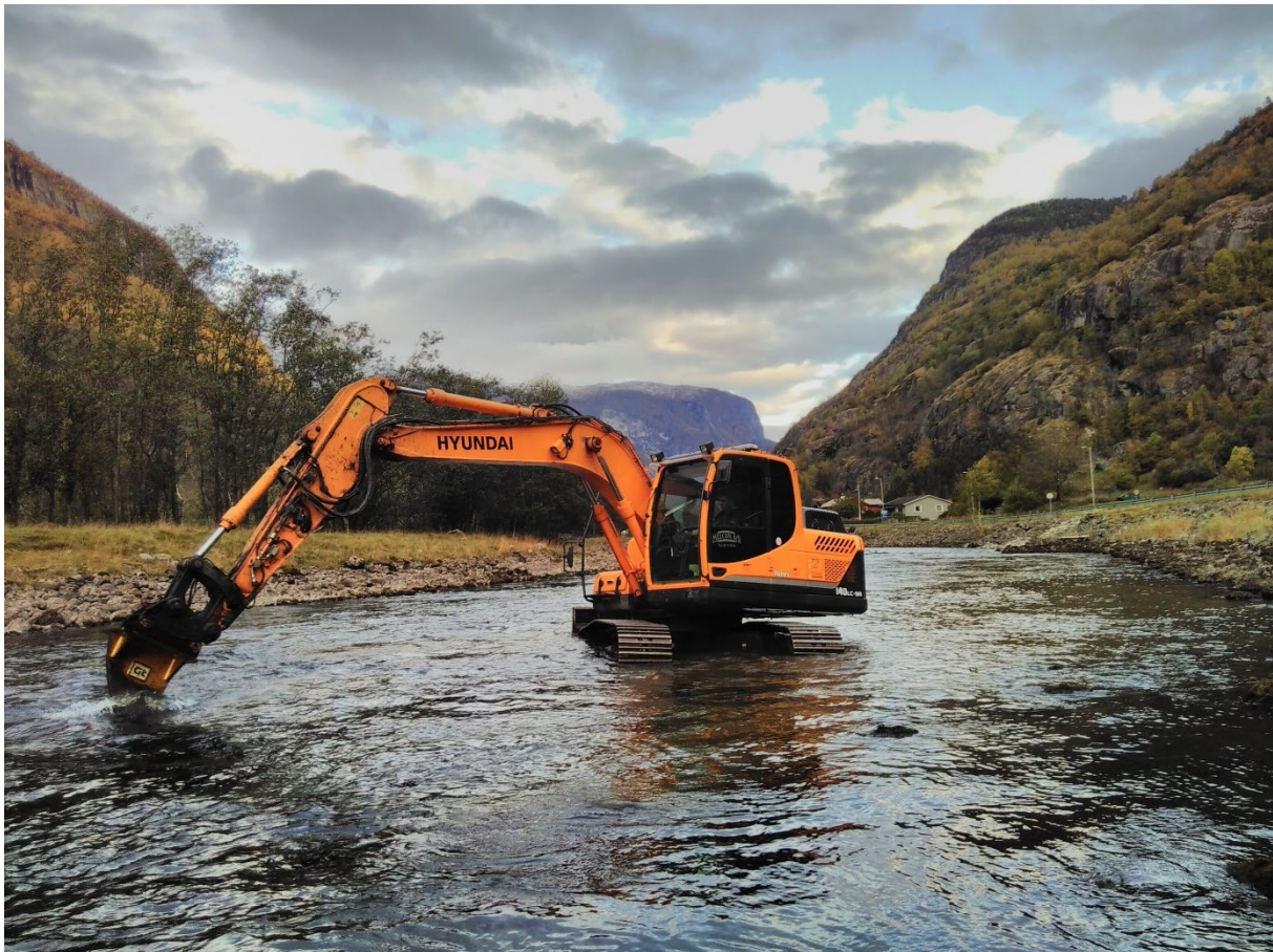
Figur 39. Bilde fra ripping ved bruk av gravemaskin og teleripper i nedre del av Aurlandselva i 2019.
