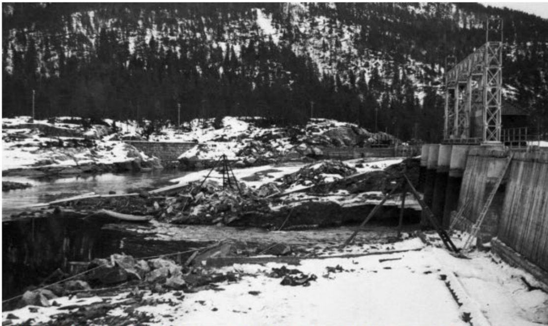
Figur 3. Til høyre i bilete vises vassløp frå fjordsida ned til hovudluker ved vasstand ned mot 198 moh (Foto: OB). Her kan fisk vandre opp utan hinder.
