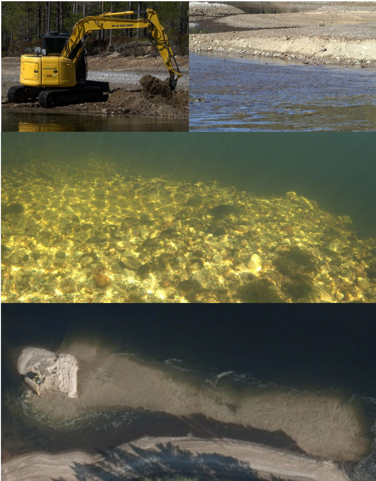
Figur 3. Bildene øverst viser senkning av grusbanken på vestre bredd ovenfor Surtefoss ( tiltak 1.3 ). Midterste bilde viser bunnforholdene etter at vannstrømmen har fjernet sanden slik at området er egnet for gyting og oppvekst av ungfisk. Nederste bilde viser flyfoto med bilde av gravemaskinen som er i ferd med å senke banken nær Langekast, dvs. tiltak 1.2 .
