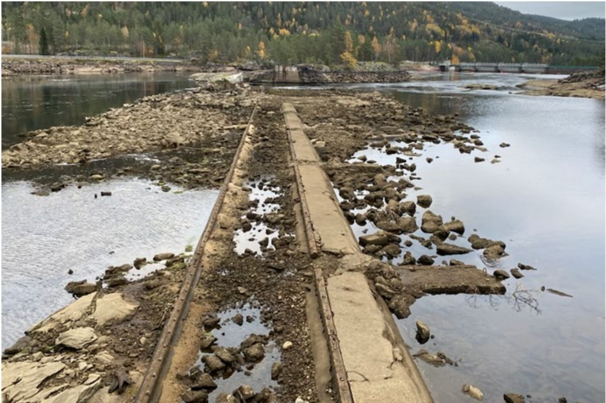
Figur 42. Foto av fundament til nåledam langs vestlig elvebredde, tatt ved vannstand på kote 200,12. (foto: Nils B. Kile, 27.10.2025)
