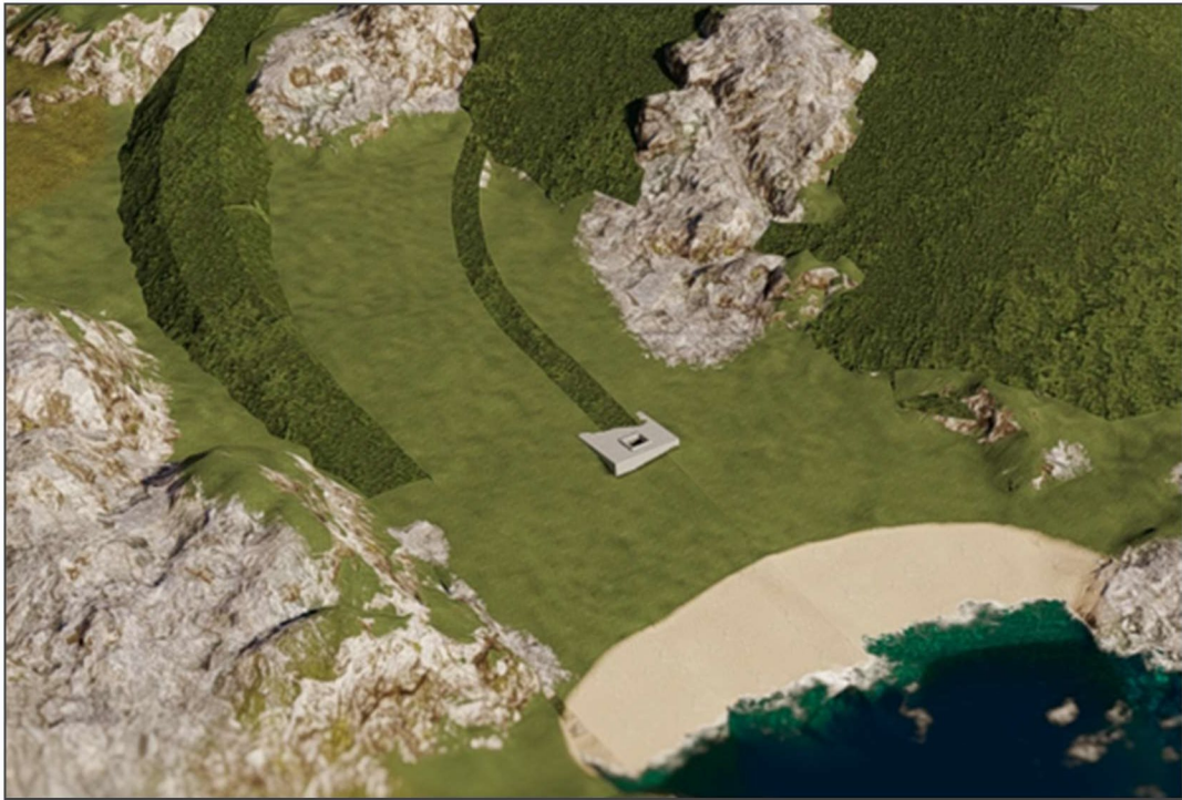
Figur 3-9. Eksempel på grøftet landfall i driftsfasen. (Ill: Multiconsult for Aker BP).
