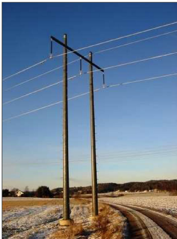
Figur 3-13. Aktuell portal bæremast i kompositt for luftledning (Foto: Multiconsult).
