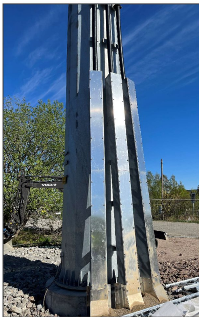
Figur 3-15. Muffeanlegg for kabelovergang til luftledning: Luftledningen på mast. Venstre: Nedre snitt av masten med muffeanlegg. Høyre: Øverste snitt av masten med kabelavslutninger
