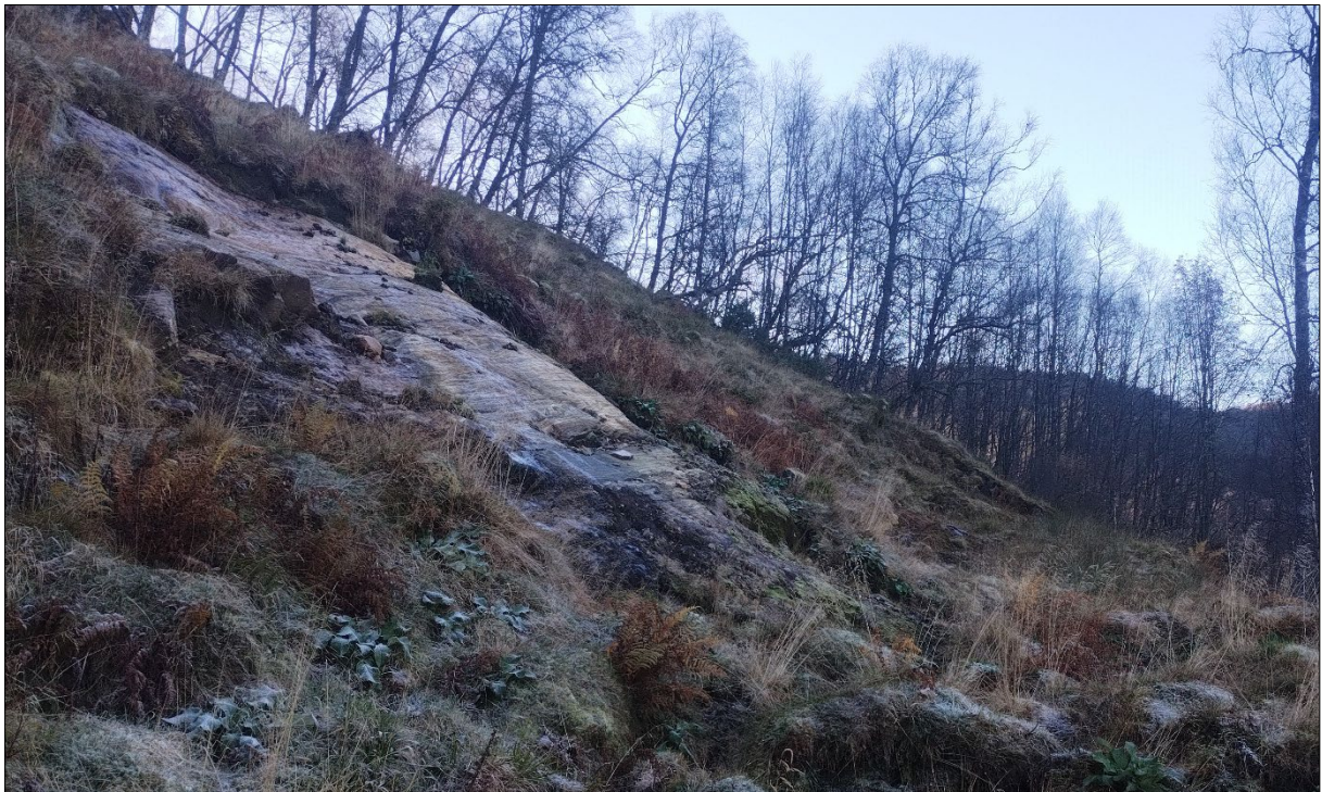
Figur 7: Fjellblotting ved infopunkt 5. Foliasjonsplana i berggrunnen har eit fall på om lag 50^\circ mot sør, inn i grunnen. Det er tolka at fjellet er reinska for lausmassar grunna ei lita jordutgliding.
