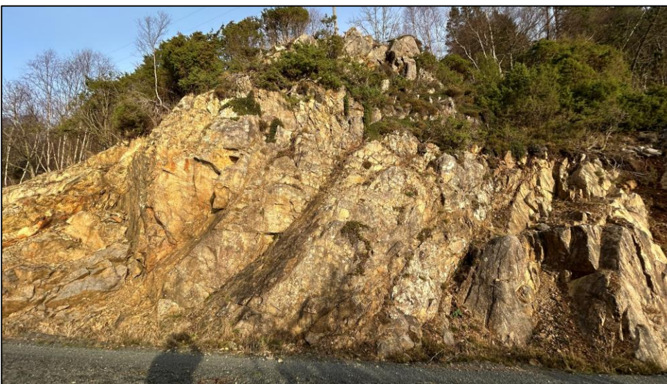
Figur 3-10. Bergskjæring langs adkomstveien inn til kraftstasjonen. Tett oppsprukket og noe forvitret berg.
