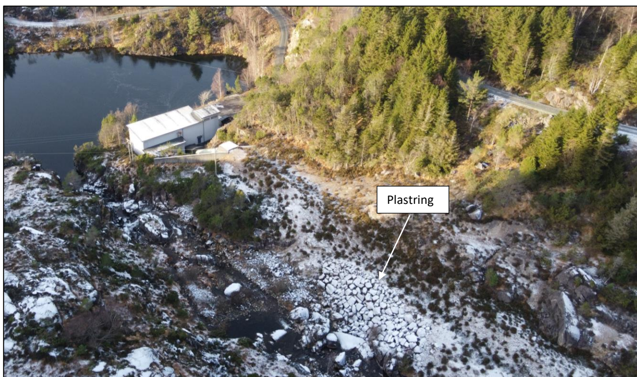
Figur 4-14. Dronefoto som viser én av to seksjoner av nedgravd rørgate hvor det er utført plastring.
