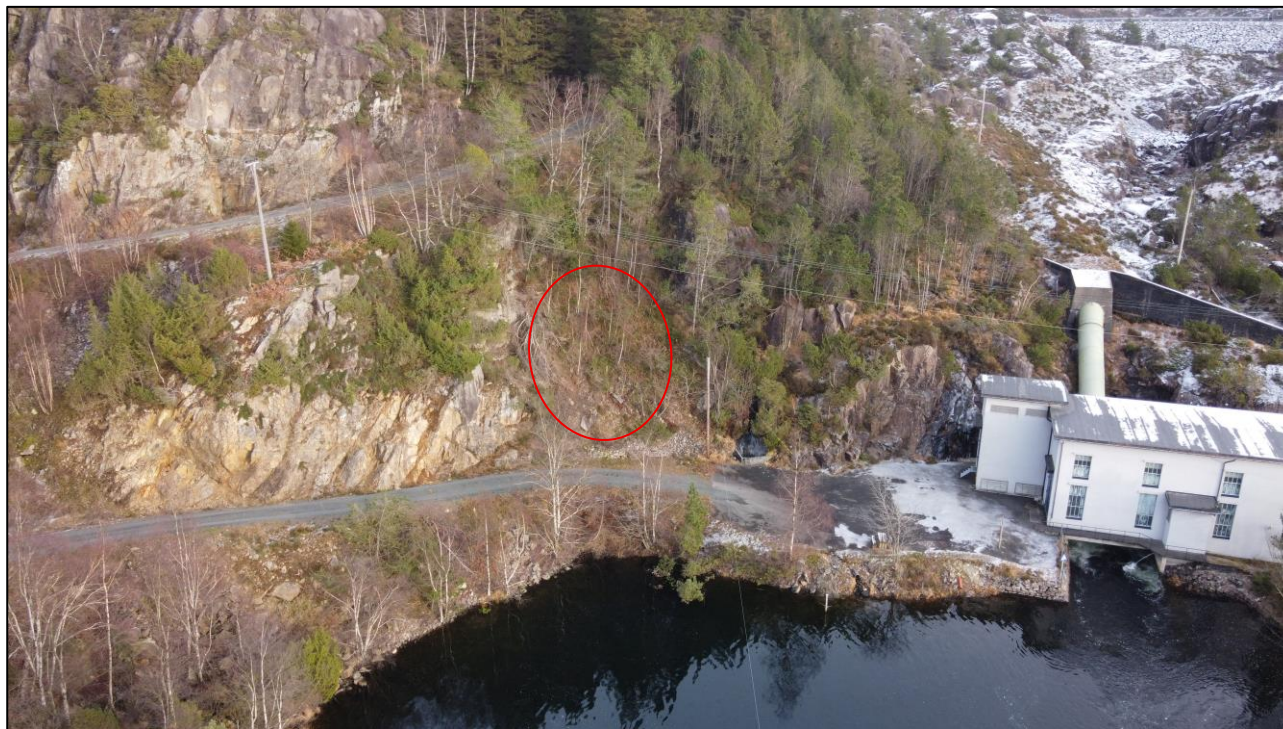
Figur 4-15. Bratt skråning uten synlig berg ved adkomstveien til kraftstasjonen.
