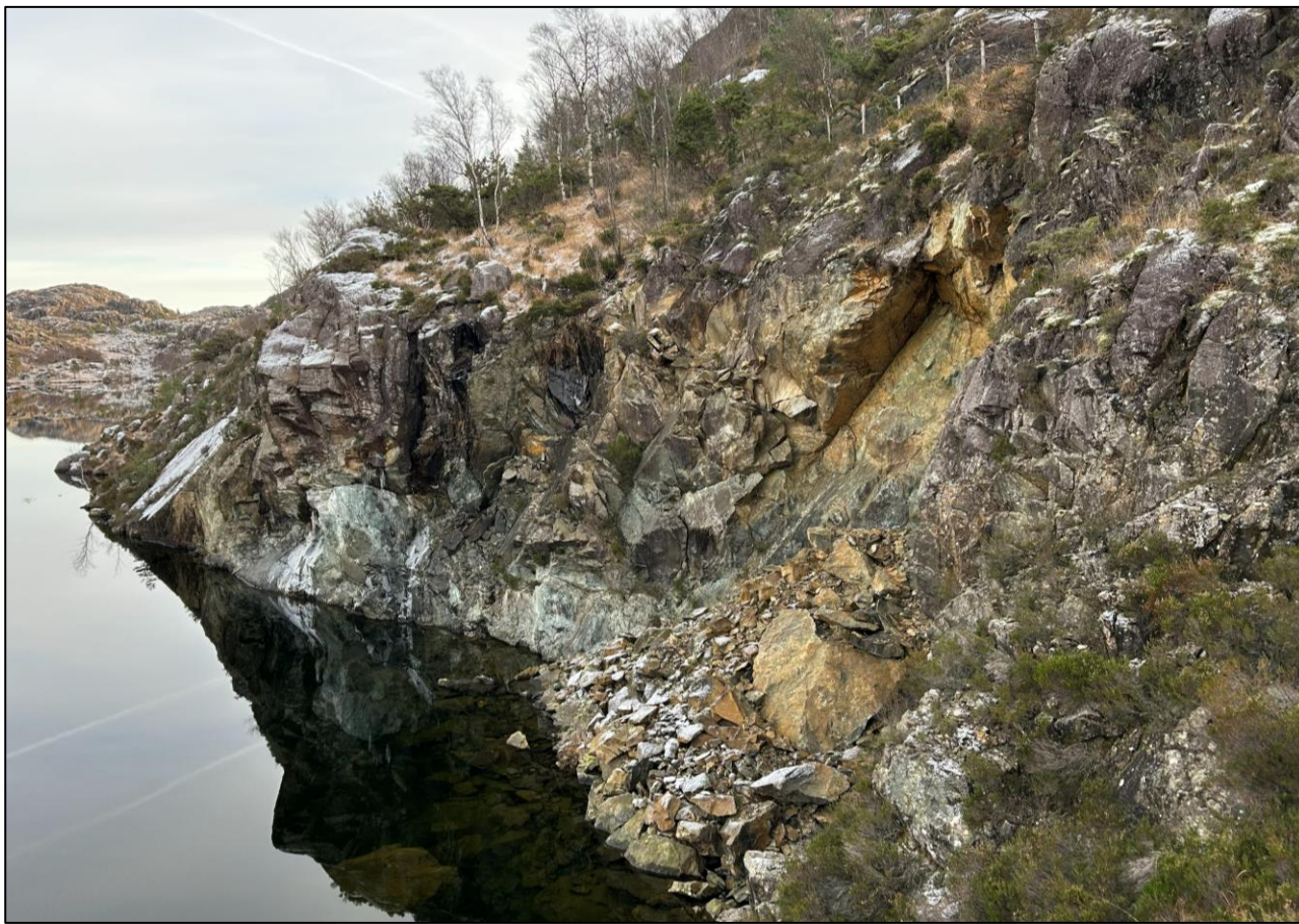
Figur 4-8. Nedfall av nyere dato ved overløpet til dam Honnefoss.
