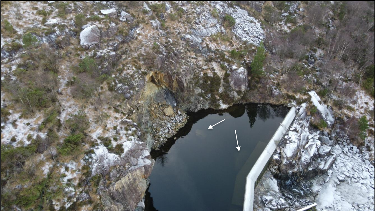
Figur 4-11. Dronefoto av overløpsområdet. To blokker på bunnen av vannet er vist med piler.
