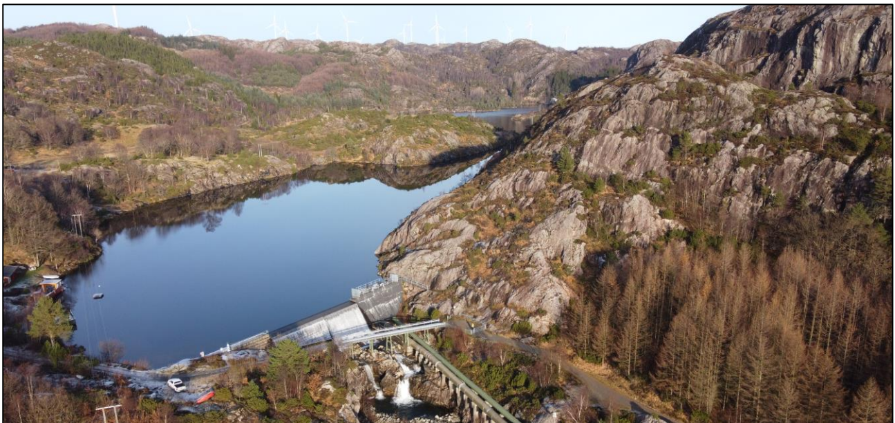
Figur 3-2. Dronefoto tatt i retning nord, som viser dam Smievatn nederst og Stidlefjellet til høyre.
