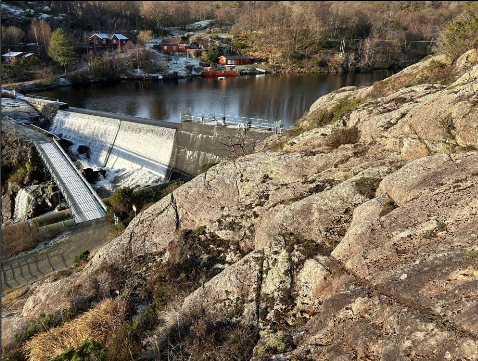
Figur 3-9. Bergblotning like øst for dam Smievatn. Sprekkene i området er relativt lite gjennomsettende.
