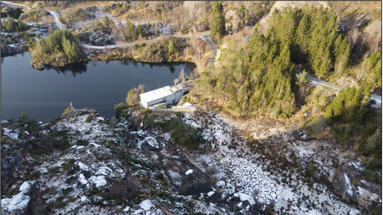
Figur 3-8. Honnefoss. Eksisterende kraftstasjon sentralt i bildet. Dronefoto tatt i retning nordvest.
