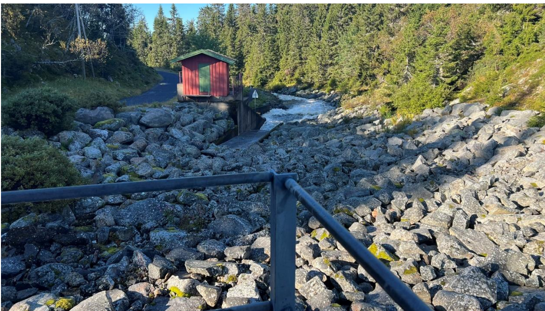
Flomløpet sett fra dammen
