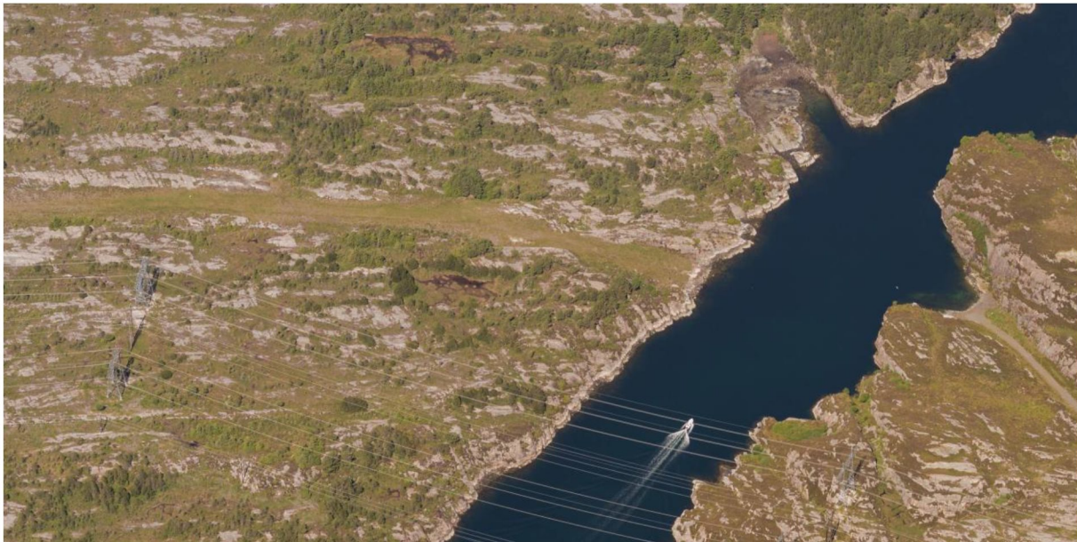
Figur 9. Flyfoto som viser Osundet med eksisterende kraftledninger. Omlagt 132 kV ledning vil krysse sundet om lag der hvor båten er på fotoet og gå videre i nordvestlig retning på venstre side av tjernet i bakgrunnen. Den gresskledd, planerte traseen nord for kraftledningene er en nedgravd gassrørledning.
