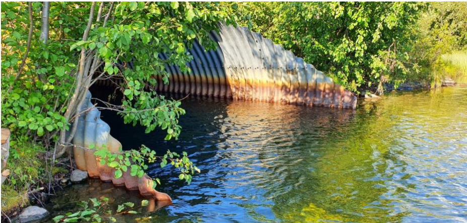
Figur 3 Dagens kulvert under vei M7. Foto: Sweco
