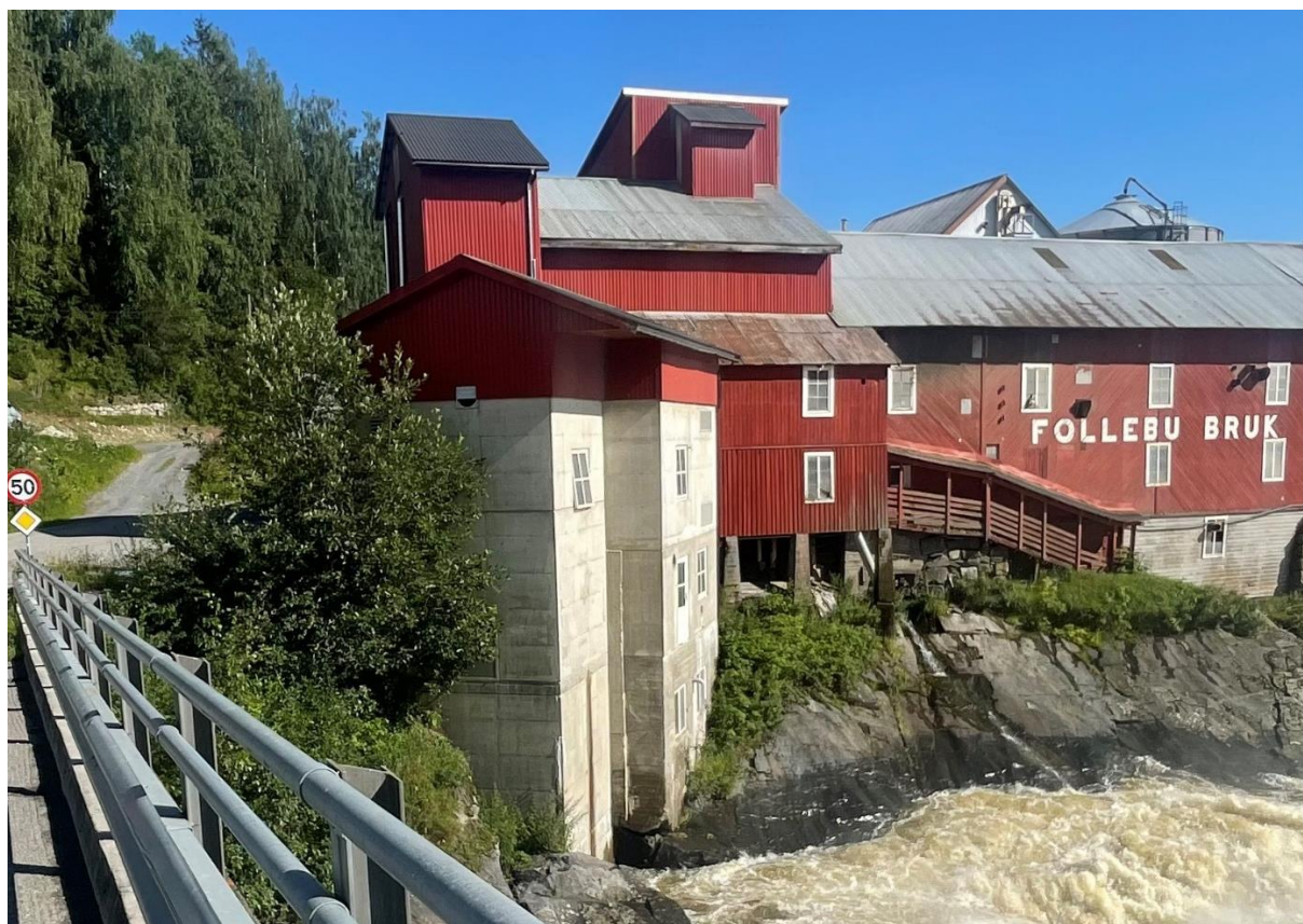
Bilde 10 Follebu kraftverk har en utforming i stil med resten av fabrikkbygningene på Follebu. Det produseres kraft for til bønder i Gausdal på bruket.
