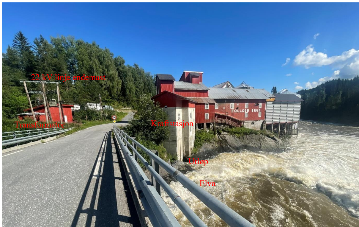
Bilde 9 Follebu kraftverk, ved flom 26.7.2023. Vannmerket Aulestad viser at det gikk ca 190 m 3 /s.
