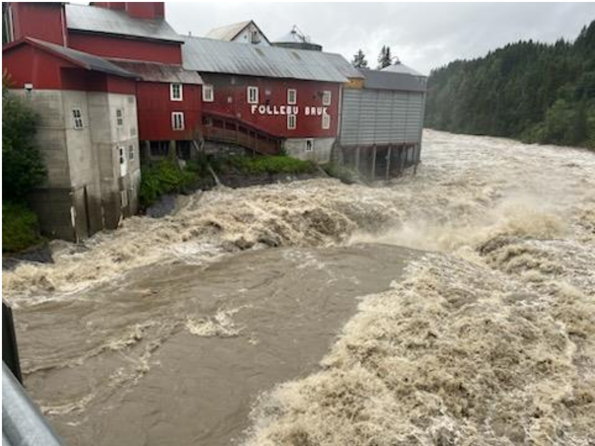
Bilde 20 Kraftstasjonen 09.08.23. 611 \text{ m}^3/\text{s} . Stor massetransport i elva.
