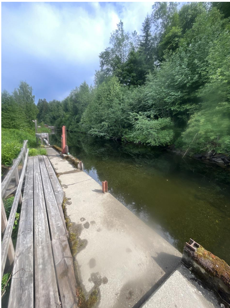
Bilde 6 Eksisterende kanal.
