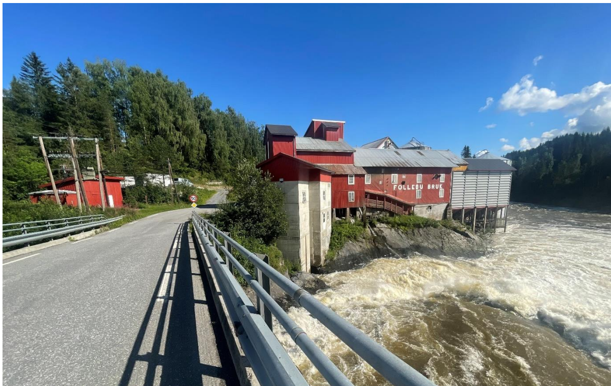
Bilde 17 Follebu kraftverk, ved flom 26.7.2023. Vanmerket Aulestad viser at det gikk ca 190 \text{ m}^3/\text{s} , dvs 182,5 \text{ m}^3/\text{s} fra elva og 7,5 \text{ m}^3/\text{s} fra kraftverksutløpet.
