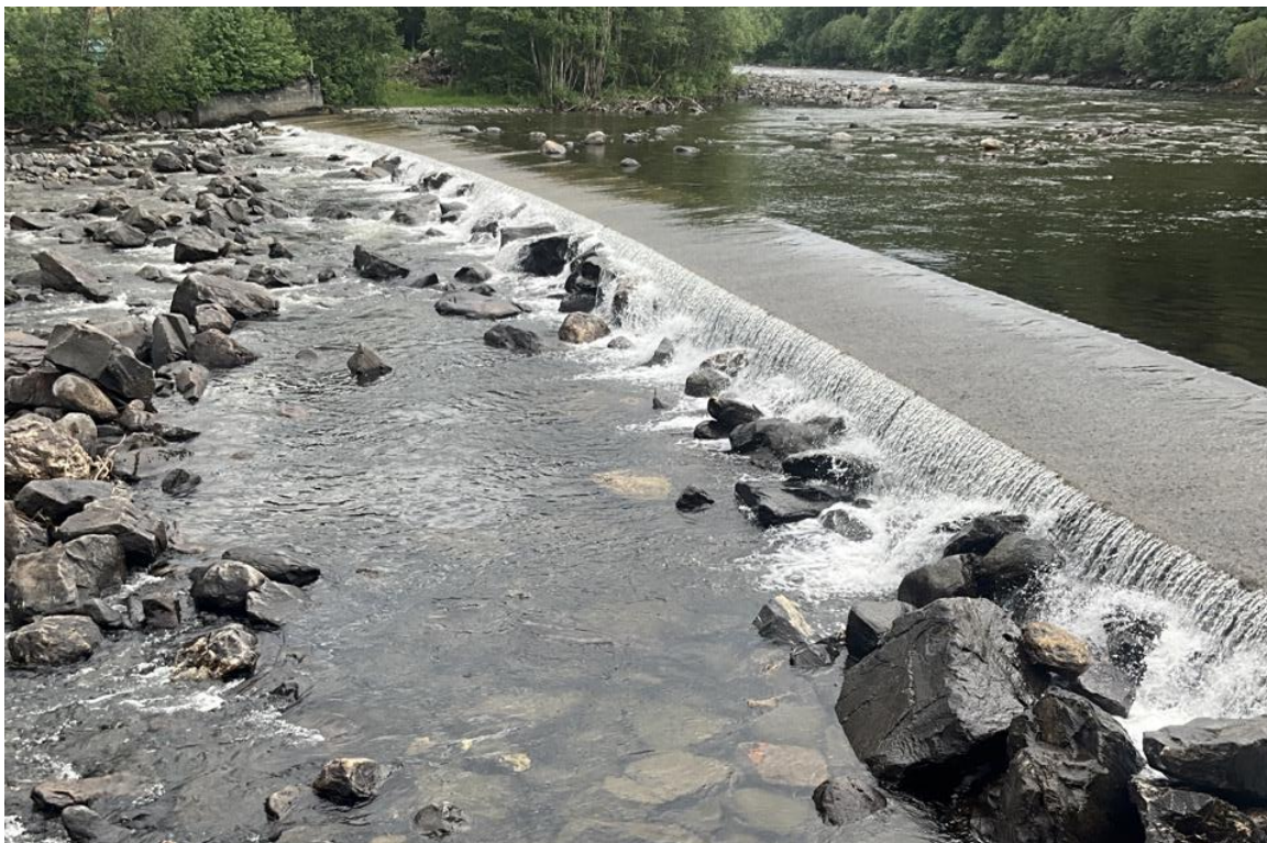
Bilde 1 Eksisterende terskel nedstrøms inntaket. Ved lavere vannføringer medfører terskelen et økt vanndekt areal på ca 2500 m 2 . Ved større vannføringer gir den ingen økning.
