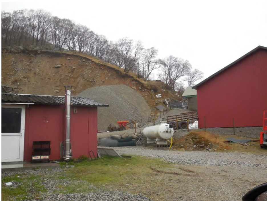
Figur 15 Massetak med ustabile blokker som kan rulle ned til et lagerbygg i område 15 - Auestad.
