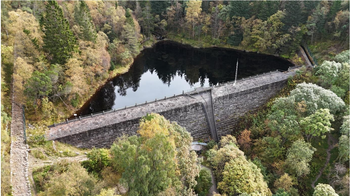
Figur 1: Dam Skredderdalen. Omløpskanal ses til høyre, og den mye brukte turstien til venstre for damanlegget.
