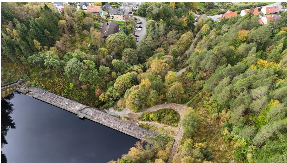
Figur 5: Boligfeltet Breistølen ses øverst til venstre i bildet. På nedsiden av demningen er Mulelven kanalisert, før den går i rør ned til utløpet i fjorden.
