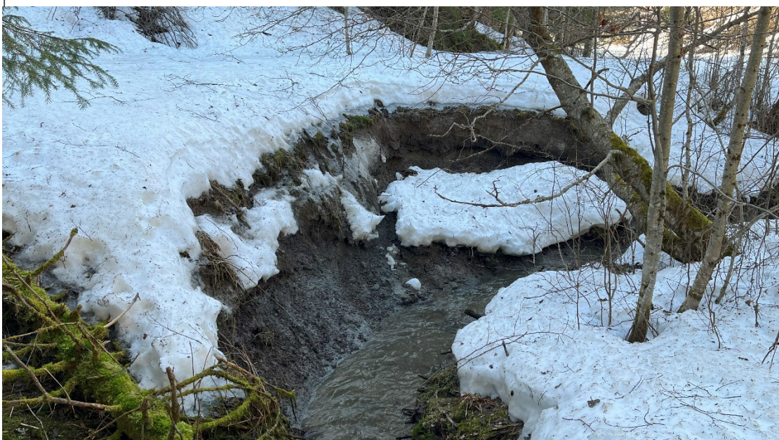
Figur 4-4 Det går skispor som følger bekken fra løpemeter LM180 til og med LM450 som kan benyttes som anleggsvei. Skisporet er ikke lengre i bruk og derfor ikke vedlikeholdt. Stedvis er traseen undergravd og behøver oppretting.
