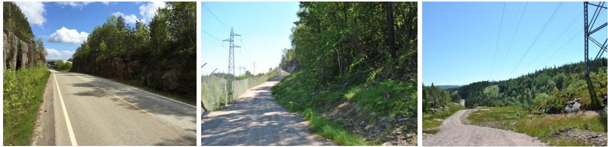
Figur 5 Fv 75 inn i området t.v., grusveien som går rundt trafostasjonen i midten og SK4-traséen t.h.
