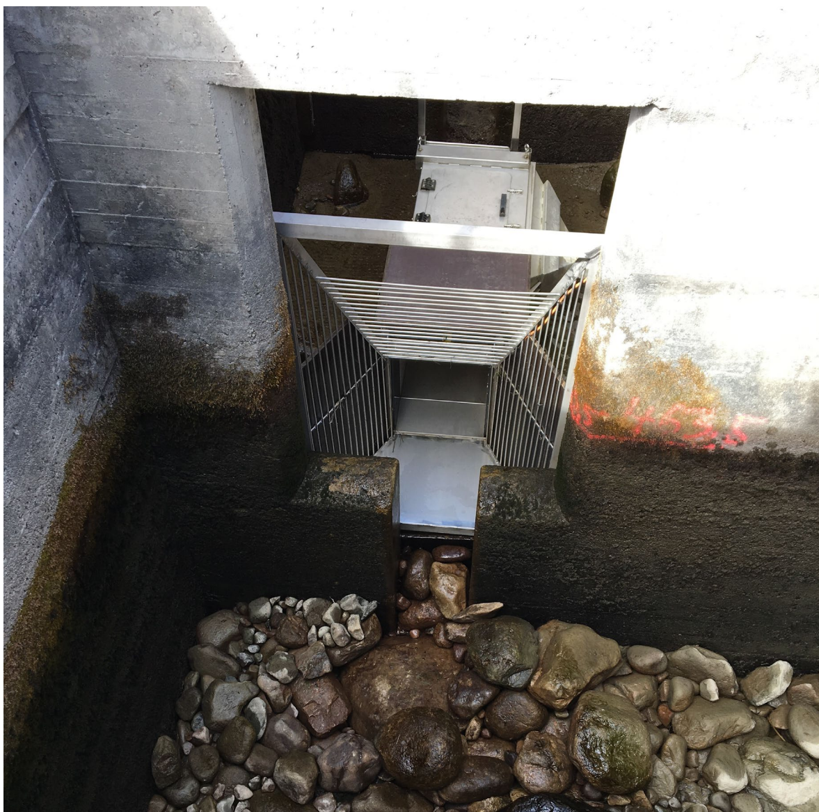
Figur 16. Inngangen til en VAKI fisketeller i fisketrappa ved Høyegga i Glomma. Trappa har blitt ombygd fra kulpetrapp til spaltetrapp for å sikre passasje for andre arter enn bare ørret i vassdraget, slik som sik og harr (Holter mfl., 2020). Foto: KM Myrvold, NINA.
