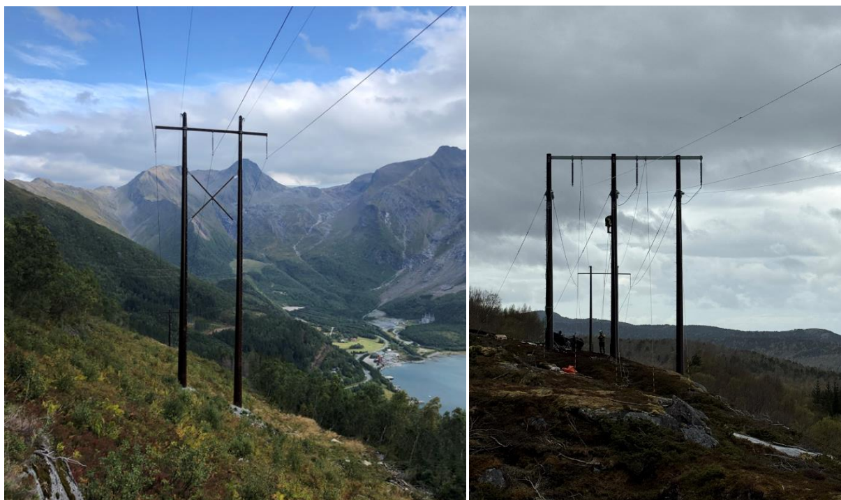
Figur 2-2: Venstre, komposittmast, her vist som H-mast med overliggende toppliner. Høyre, vinkelforankringsmast kompositt, her vist som en 3E-mast med barduner
