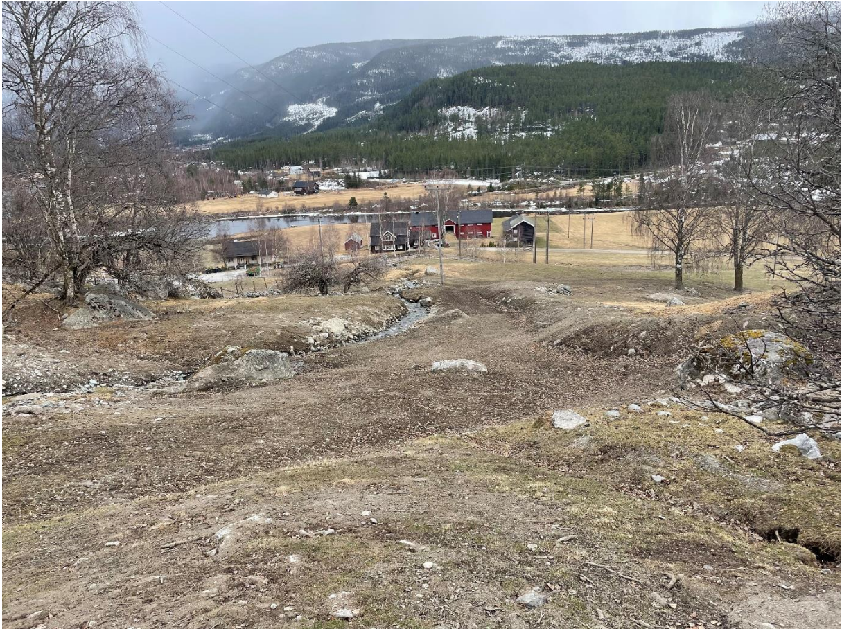
Figur 11: Nedre del av skredløpet ved Nordre Oppsata. Det er bygd en lav voll til høyre i bilder.
