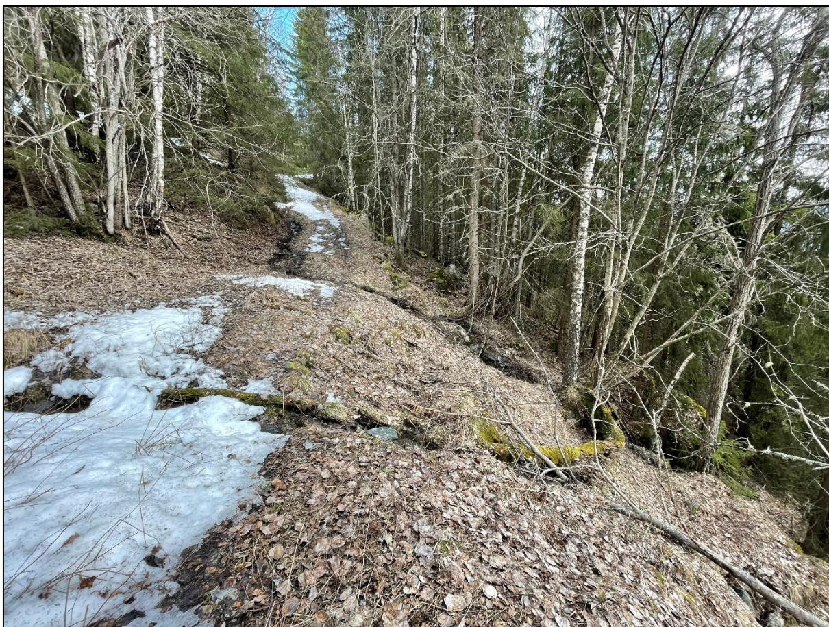
Figur 6: Bildet er tatt på befaring 2024-04-25 og viser en av skogsbilveiene som går parallelt med fjellsiden i det kraftig ravinerte området ovenfor Sando barnehage. Bildet viser at vann kan renne langs vegen, og avrenningen kan avskjære ned i bratt terreng.
