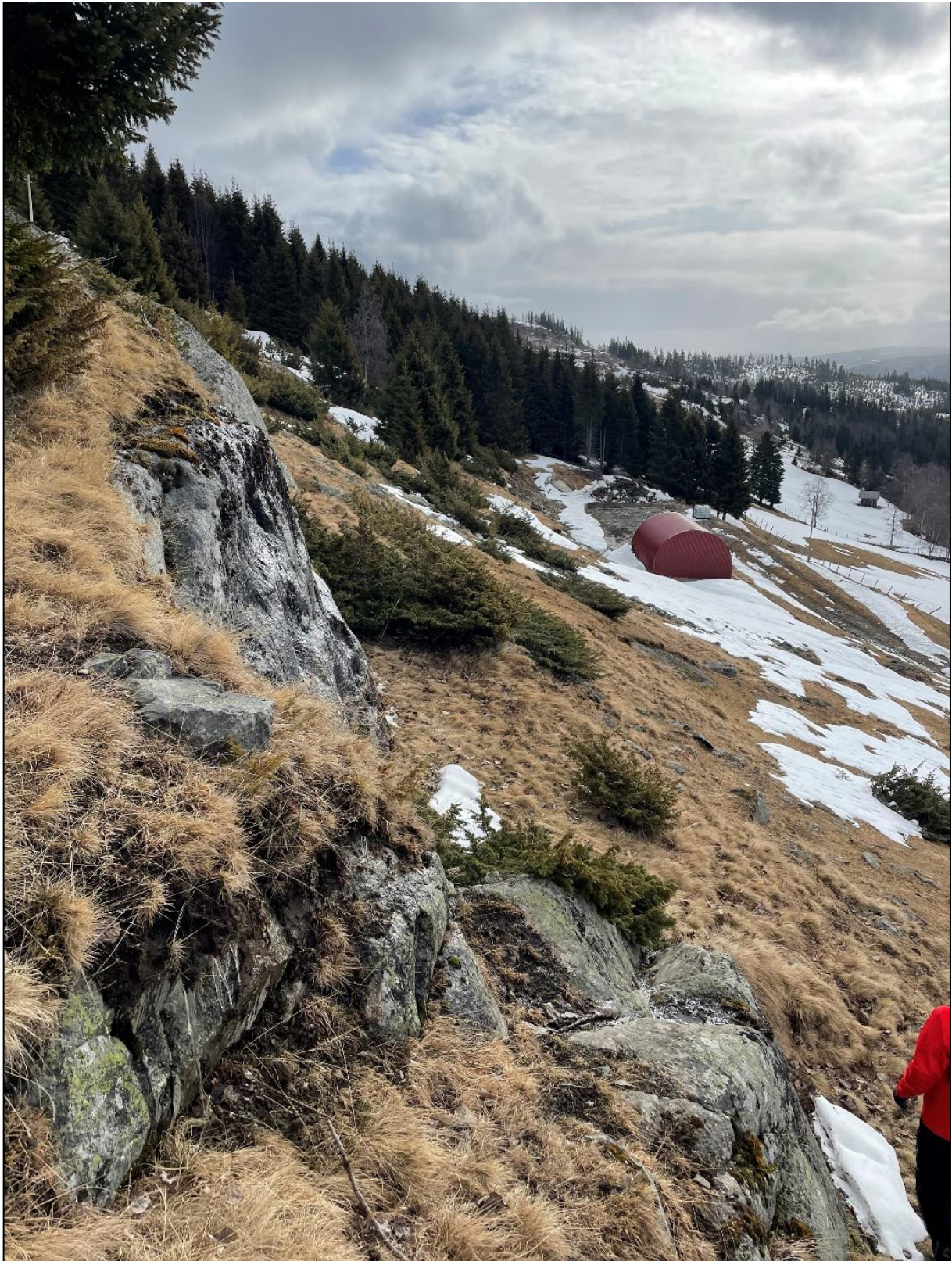
Figur 4: Bildet er tatt like ovenfor Høgset på befarings 2024-04-25 og viser berg i dagen. Berget fremstår massivt. Og løsnesansynlighet vurderes som mindre enn 1/5000.
