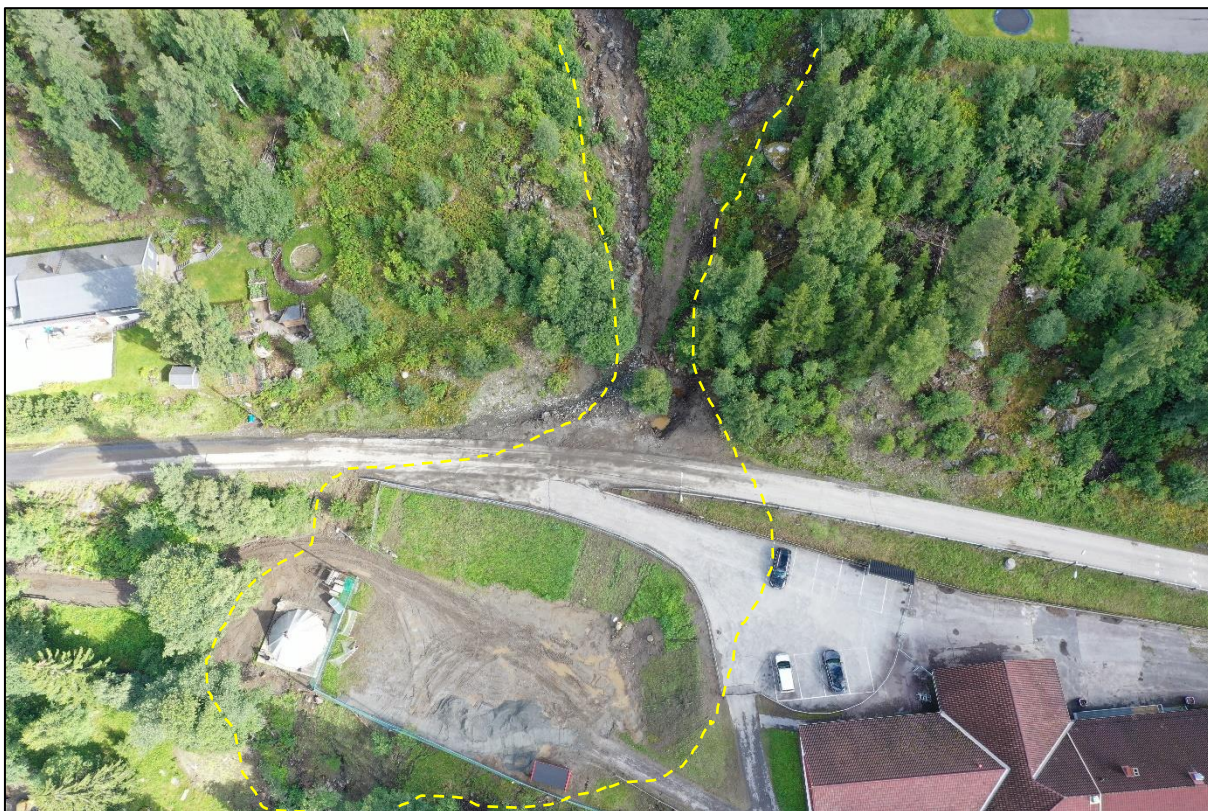
Figur 3: Bildet viser nedre del av utløpet av skredløpet ned mot barnehagen ved Sando (bygget til høyre). Bildet er tatt noen dager etter hendelsen, og noe masser er derfor ryddet bort. Gul stiptet linje viser omtrentlig utløp av skredet, hvorav store deler av dette utløpet besto av vann og finmasser/slam.
