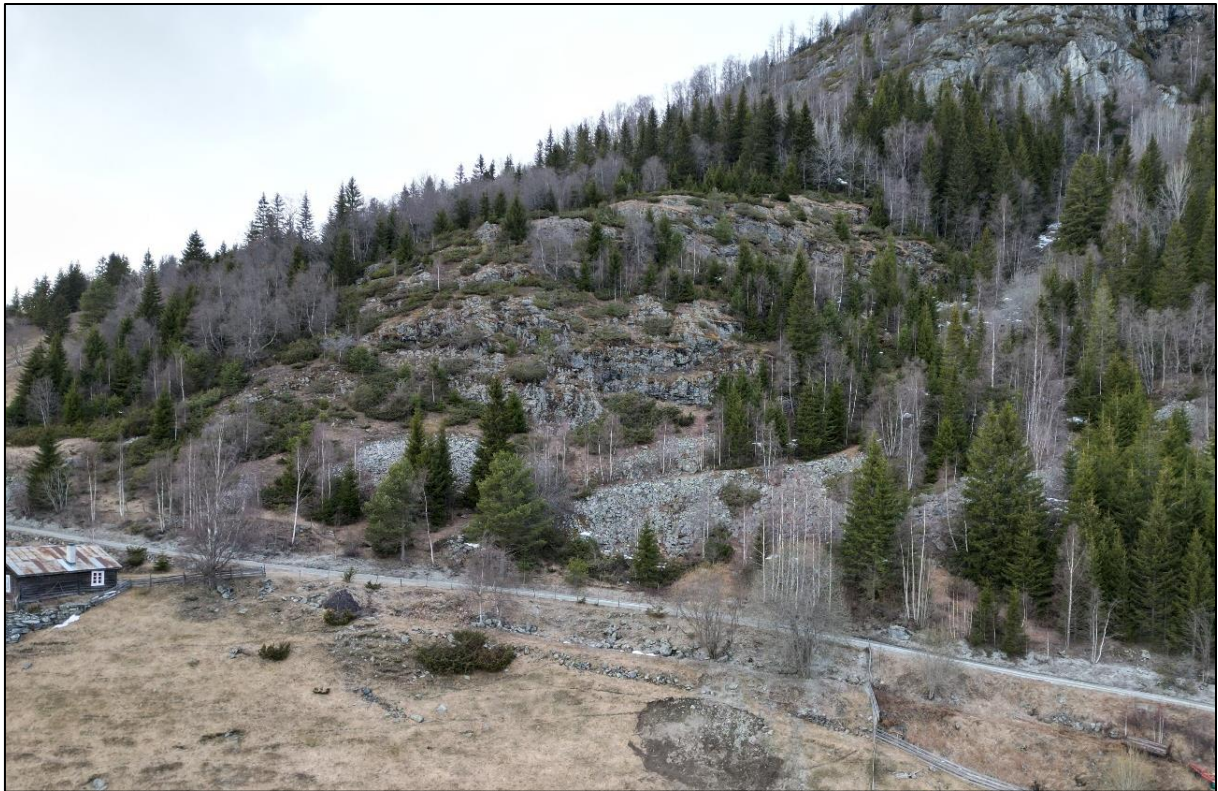
Figur 7: Bildet viser løснеområder i østlige del, med ur i nedkant som stopper ovenfor Bøygardsvegen. Løsnensannsynlighet vurderes som større enn 1/100
