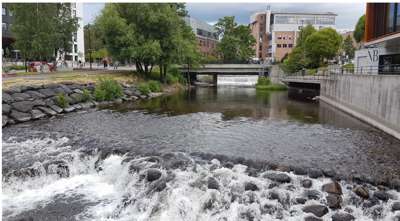
Figur 1 Terskel over T-bane kulvert med Gullhaug bru i bakgrunn
