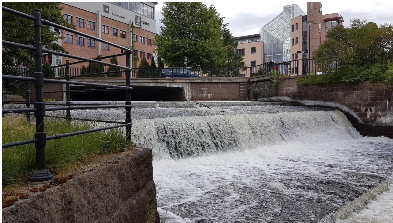
Figur 2 Terskel ovenfor Gullhaug bru med utløp til Riksteatret-kulverter i bakgrunn
