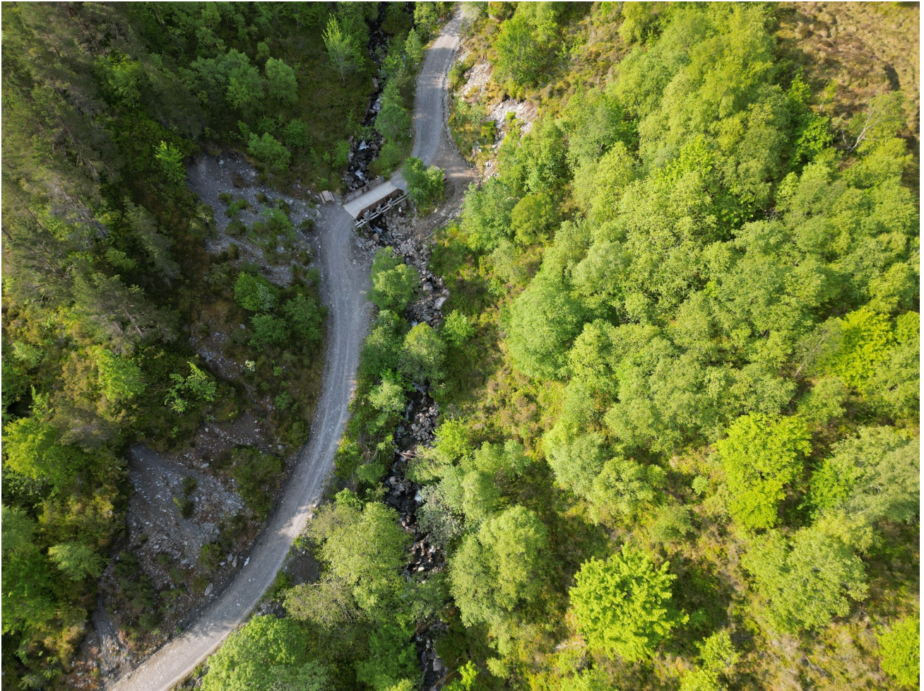
Bilde 3. Dronefoto av Molvørselva. Turvegen undergraver ravineskråningen, som medfører erosjon i morenemassene. Vegen danner en barriere mellom skråningen og elva.
