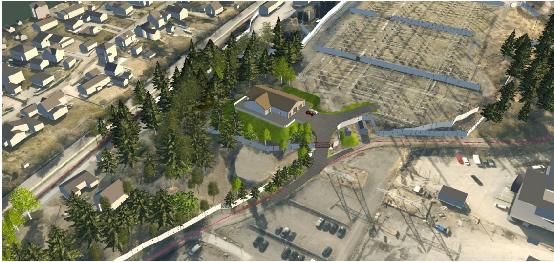
Oversikt over tiltaket, sett mot sørøst
