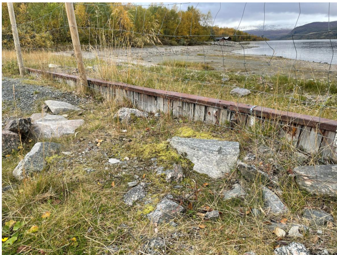
Bilde av dagens terskel ved utløpet i Osen.
