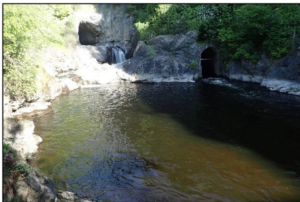
Bilde 70: Huntonkulpen. Driftsvannet til Brufoss kraftverk kommer ut til høyre i bildet.
