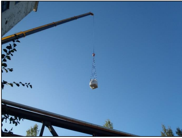
Bilde 72: Grus i storekk løftes ut over Hunnselva.
