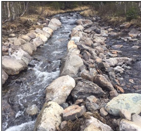
Bilde 10: Løggas utløp etter at tiltak ble gjennomført. Foto: Odd Arne Gjerden
