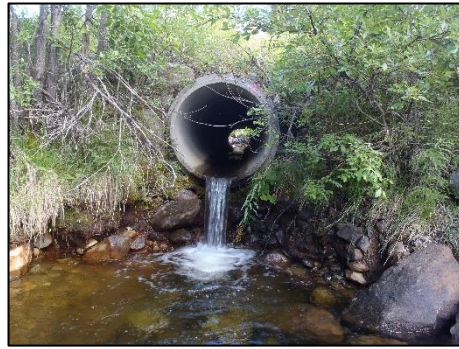
Bilde 35: Holbekken i kulvert
