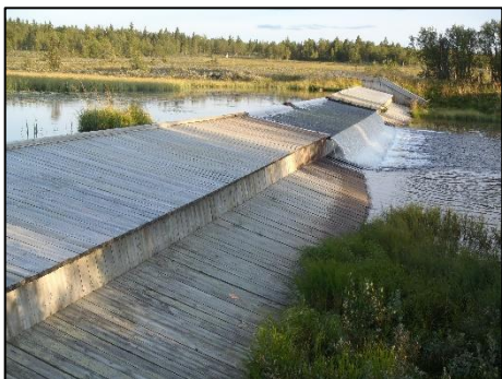
Bilde 51: Dammen på utløpet av Grunnesvatnet.
