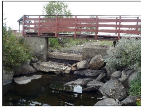
Bilde 4: Gurisetbekken under gangbru ved Oset Høyfjellshotell.
