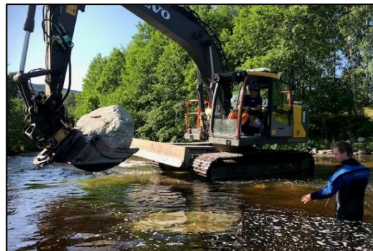
Bilde 67: Utlegging av steinblokker. Foto: Trond Taugbøl.
