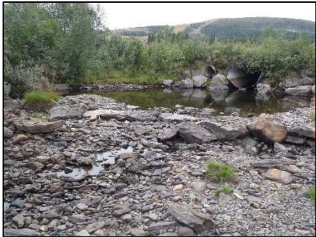
Bilde 5: Gurisetbekken rett nedenfor Golsfjellvegen. Vanninntak til den utgravde dammen er til venstre i bildet, mens opprinnelig bekkeløp er i framkant av bildet.
