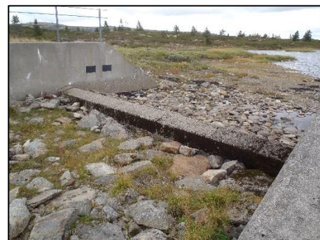
Bilde 40: Betongterskelen øverst i fiskerenna forbi dammen på Goppollvatnet. Det er laget et skår for vanngjennomstrømning på venstre side av terskelen.
