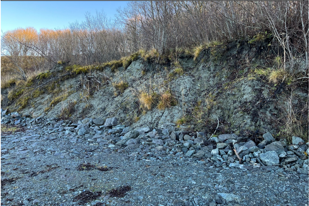
B8 - Retning mot nord. Erosjonssår ved tidligere ras i 1982
