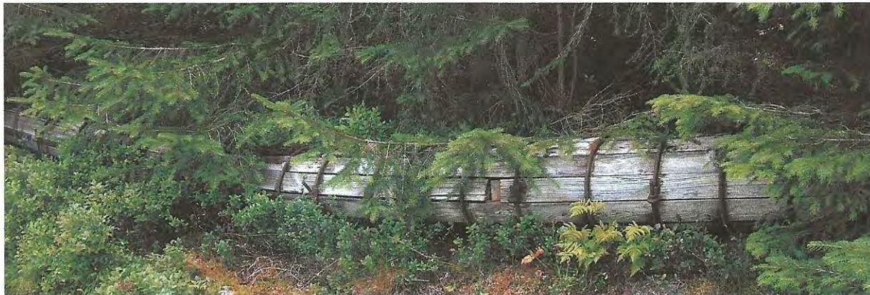
Bilde viser den gamle trerøyra som ligg mellom tunet på Harastølen og Døsjagrovi (Røsetelva). Diameter på 30 cm, den førde vatn til Sausveiti.
